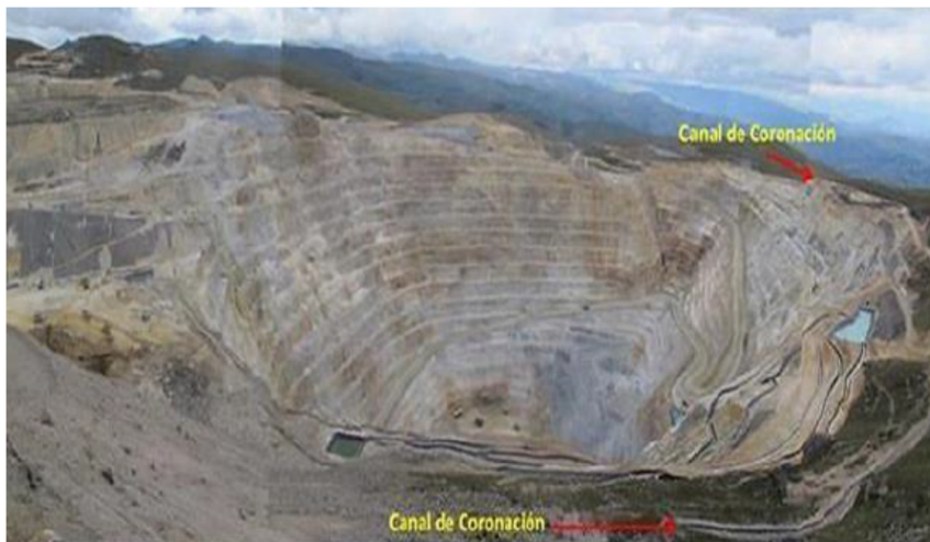
Foto 6.1-3 Canales de Coronación para Manejo de Escorrentía en Área Externa de Tajos
