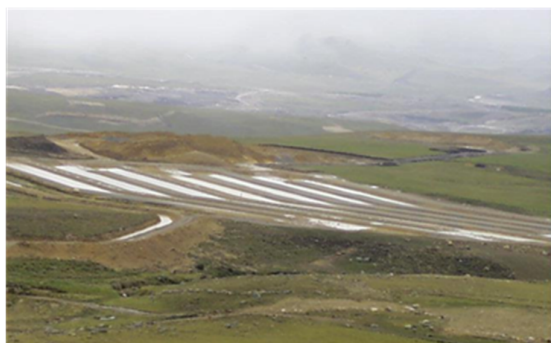
BMP de control de sedimentos intermedios
