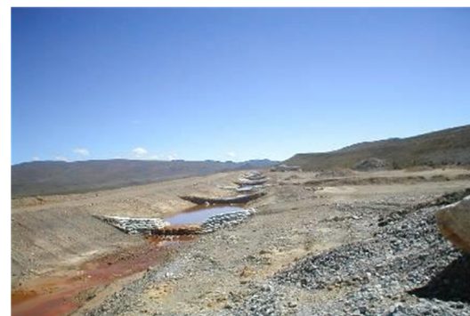
BMP de control de sedimentos intermedios
