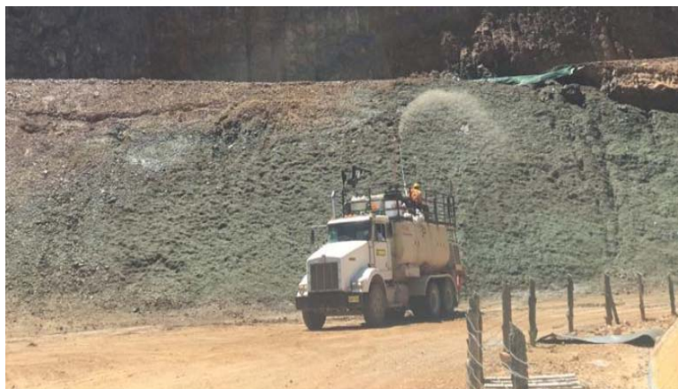
Revegetación de talud con hidrosiembra
