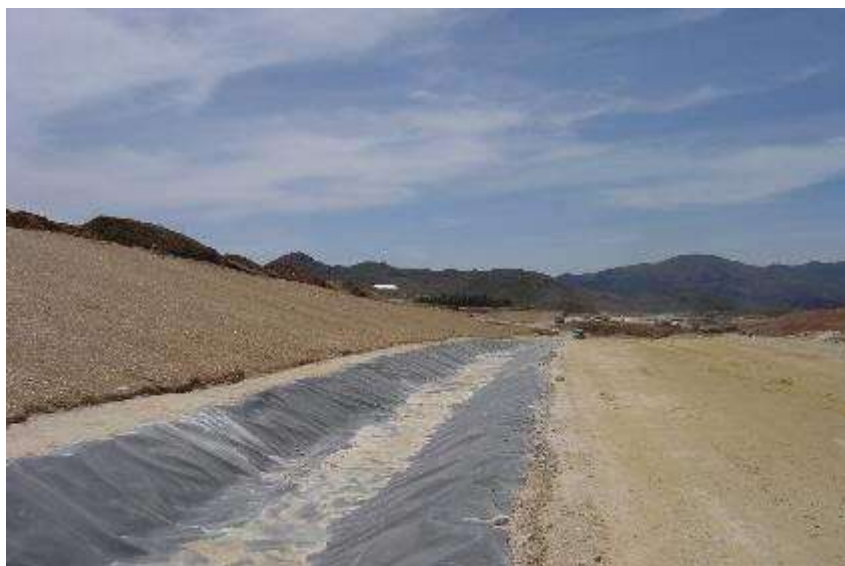
Foto 3 BMP de control de la fuente – Manejo de Aguas (canal de derivación) y biomanta en talud.
