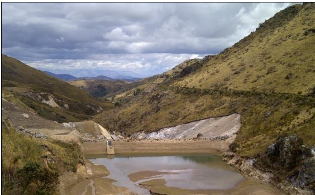
Fotografía 5 Estructura de control de sedimentos Dique Río Azufre
