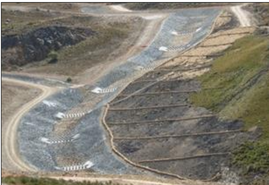
Fotografía 10 Disipadores de energía potencial
