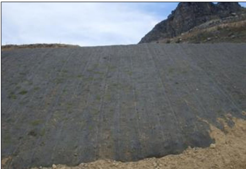
Fotografía 8 Malla estabilizadora de talud
