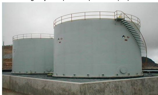
Figura N° 2 Berma y gradiente en sistema de contención para tanques de almacenamiento de hidrocarburo.
