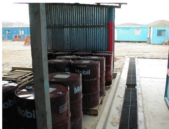
Figura N° 6 Sistema de contención para almacenamiento de hidrocarburos en cilindros.
