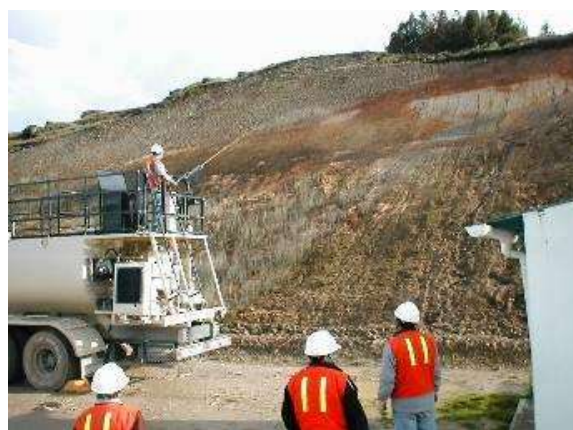
Foto 17 Hidrosembrado (hidráulico) de un talud del camino
