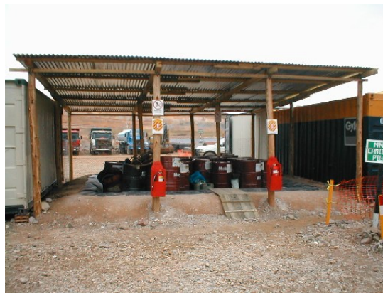
Figura N° 5 Sistema de contención para almacenamiento de hidrocarburos en cilindros.
