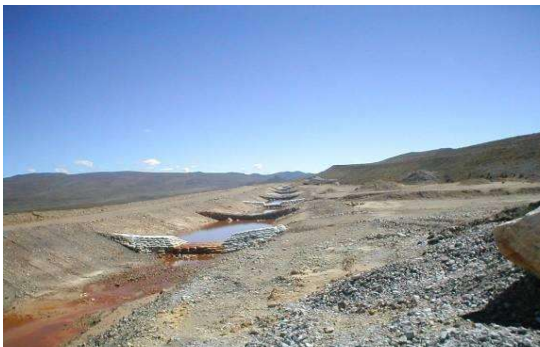
Foto 22 Aplicación de las presas de retención
