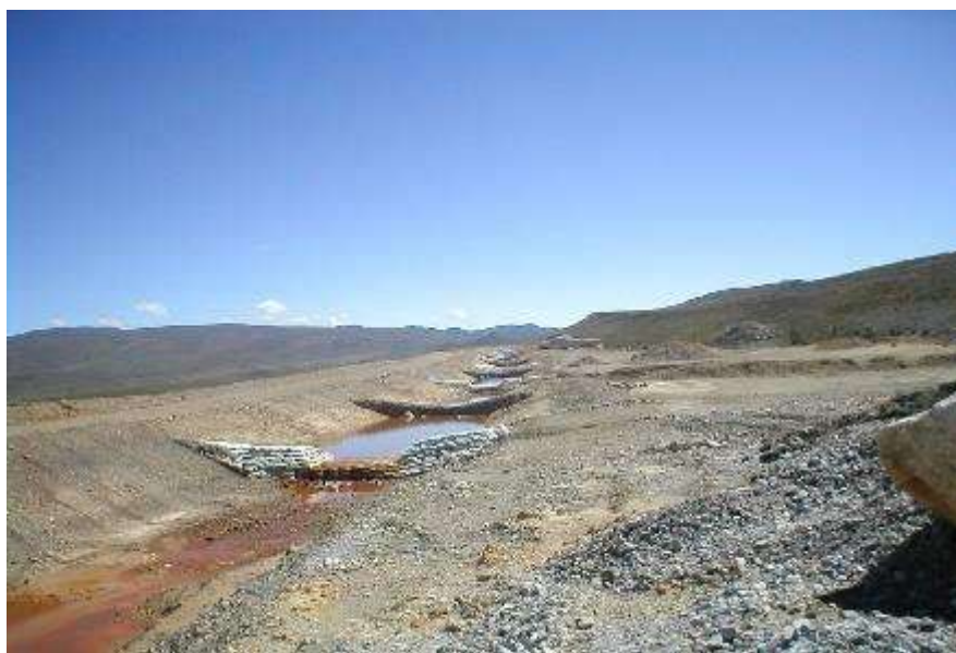
Foto 5 BMP de control de sedimentos intermedios – Presas de retención
