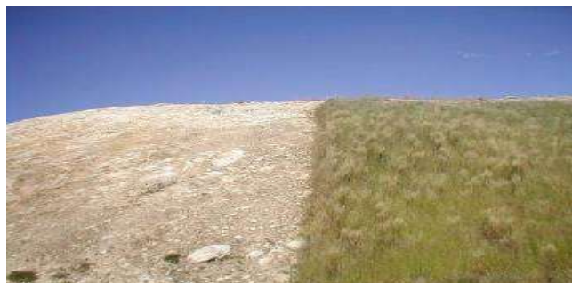
Foto 2 BMP de control de la fuente – Restauración de talud de corte del camino con geocelda, capa superficial del suelo e hidrosembrado comparado con el talud no restaurado
