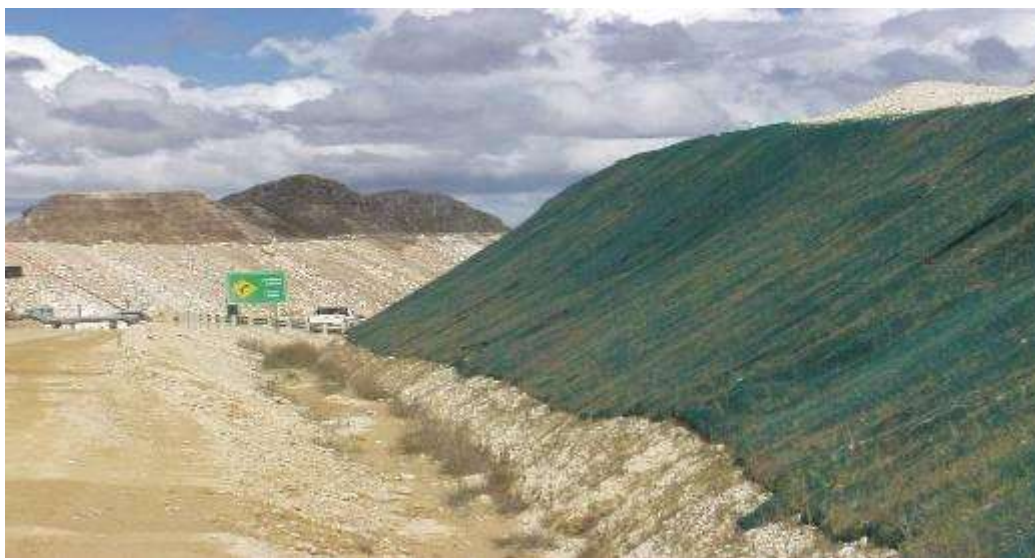
Foto 18 Mantas para el control de la erosión
