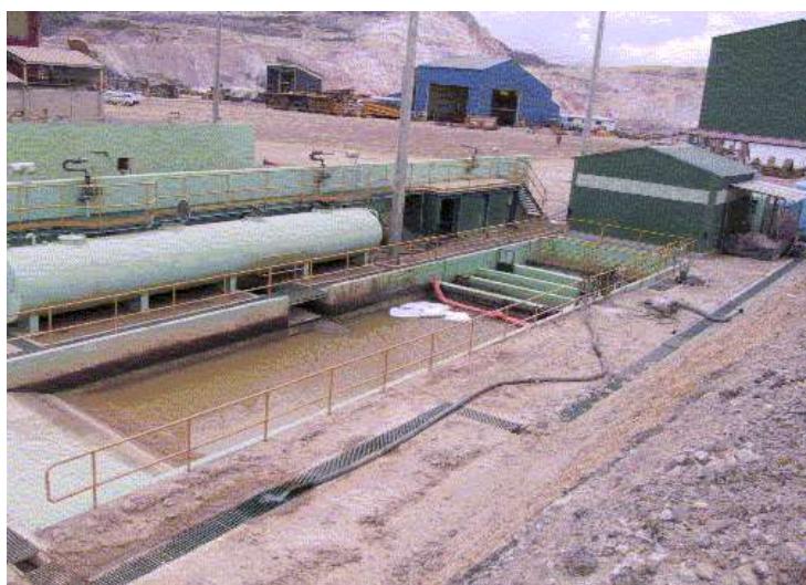
Figura N° 2 El agua, los hidrocarburos y sedimentos caen en la plataforma de concreto y drenan hacia un sumidero o poza donde se produce la separación de hidrocarburos y la sedimentación
