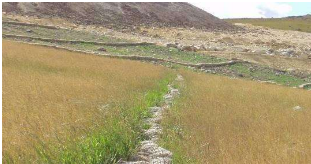
Foto 10 Progreso de restauración progresiva de depósito de material inadecuado (De la parte posterior al frente - 1: Descarga, 2: Conformación a talud de diseño, 3: Restauración; 4: Cubierta de revegetación)
