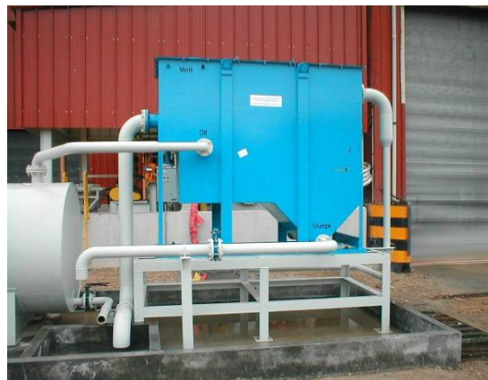
Figura N° 4 Sistema separador de hidrocarburo (trampa de hidrocarburos).
