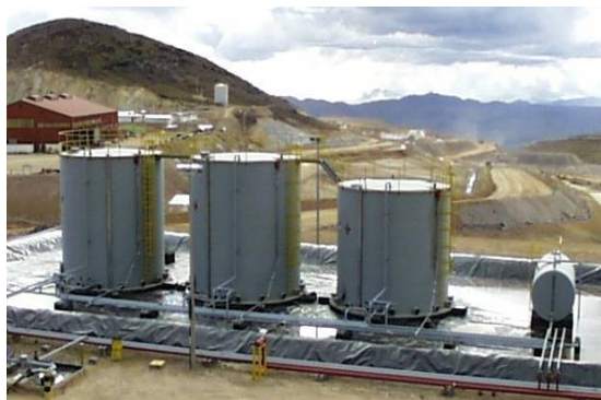
Figura N° 1 Sistema de contención para tanques de Almacenamiento de hidrocarburo
