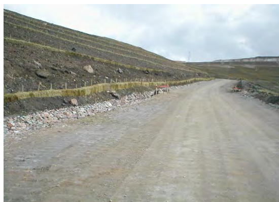
Figura N° 2 Vía con drenaje adecuado y taludes restaurados.
