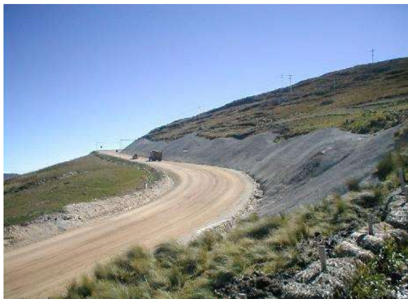
Foto 14 Talud de corte con PAG encapsulado usando concreto lanzado (shotcrete)
