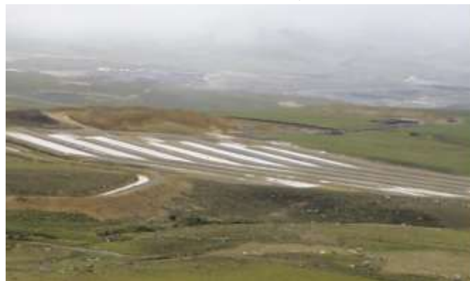
Foto 4 BMP de control de sedimentos intermedios – Serpentine Multi-celdas
