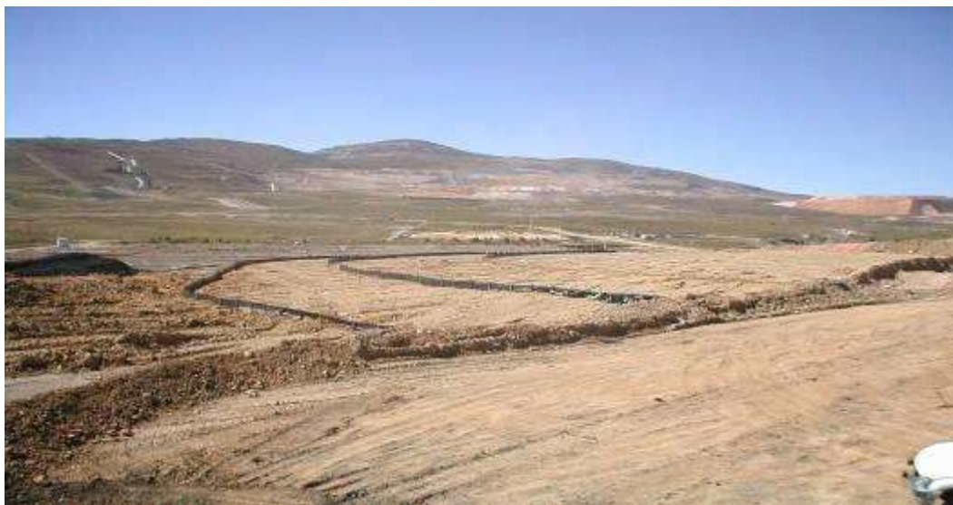
Foto 21 Aplicación de la cerca de sedimento
