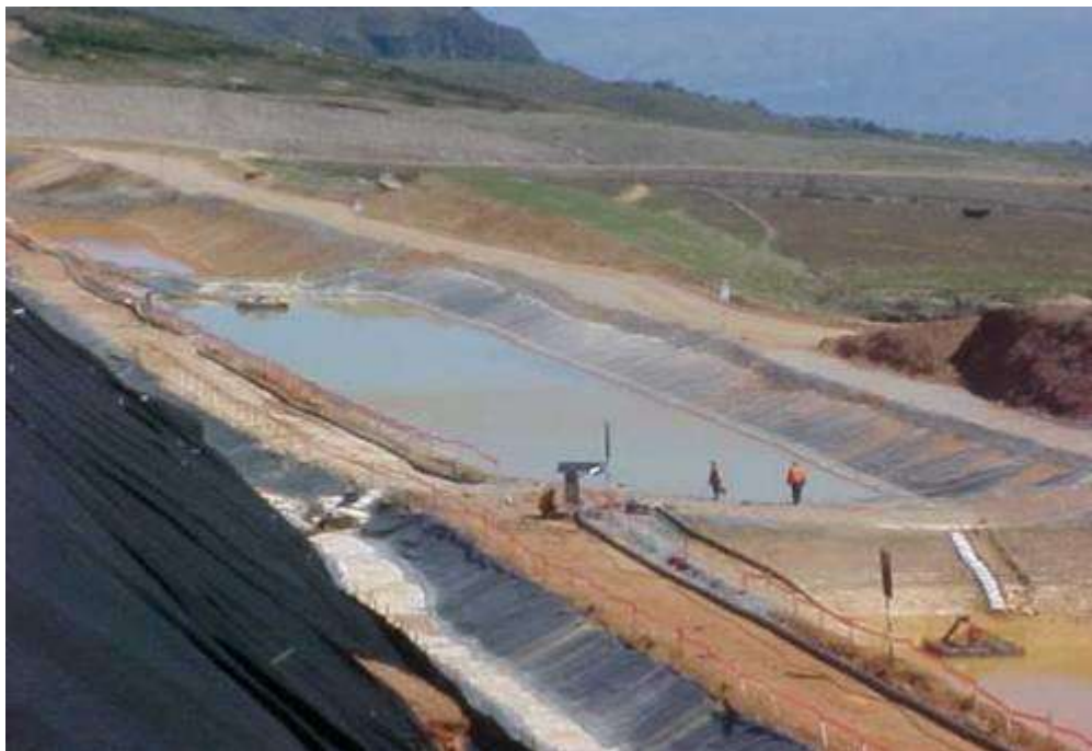
Foto 9 BMP de poza de control de sedimentos en la desembocadura de drenaje del tajo
