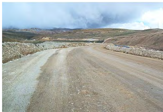
Figura N° 4 Riego de vías para el control de polvo.
