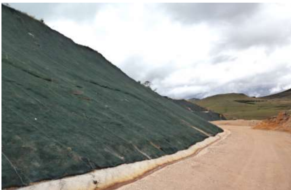
Foto 7 Corte de camino protegido con Geomanta
