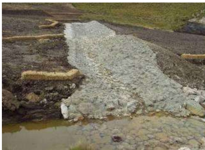
Foto 12 Canal con rip-rap con lechada de concreto
