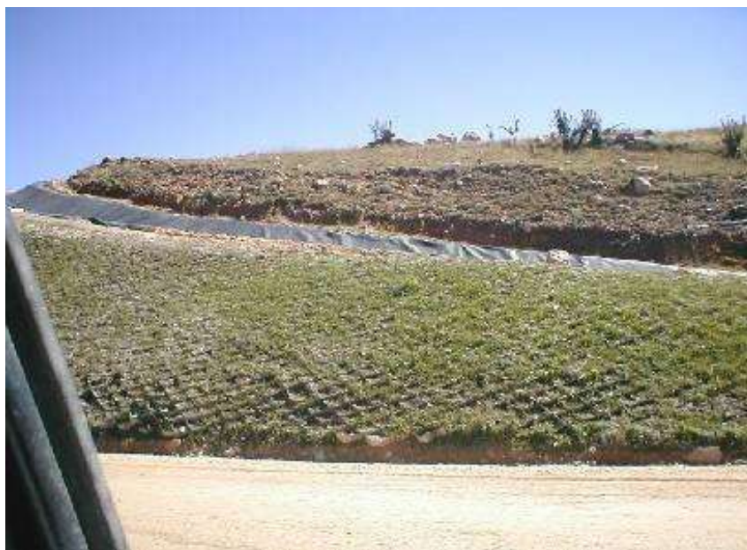
Foto 13 Restauración de talud en etapa inicial con geoceldas, capa superficial del suelo e hidrosembrado
