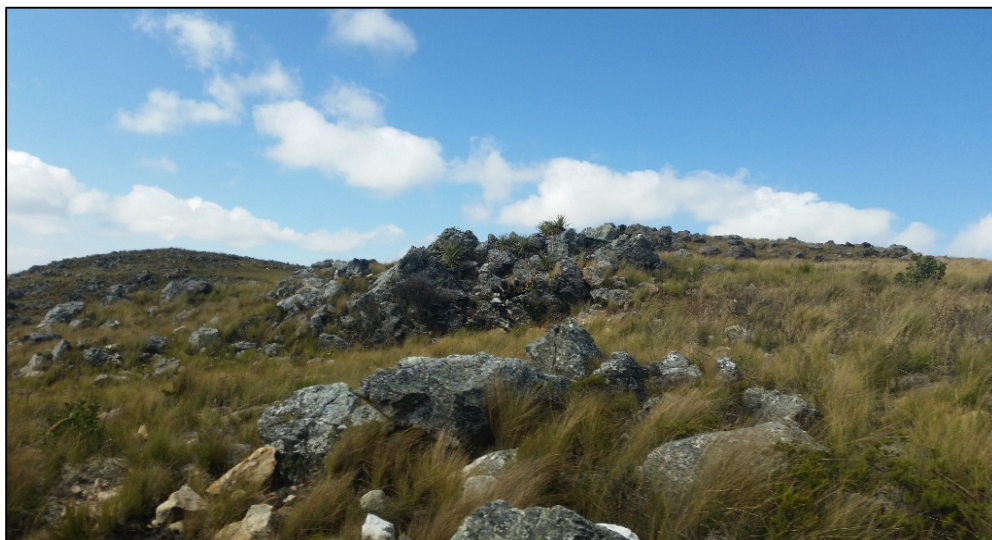
Caída de roca localizado cerca a al tajo Maqui Maqui.
