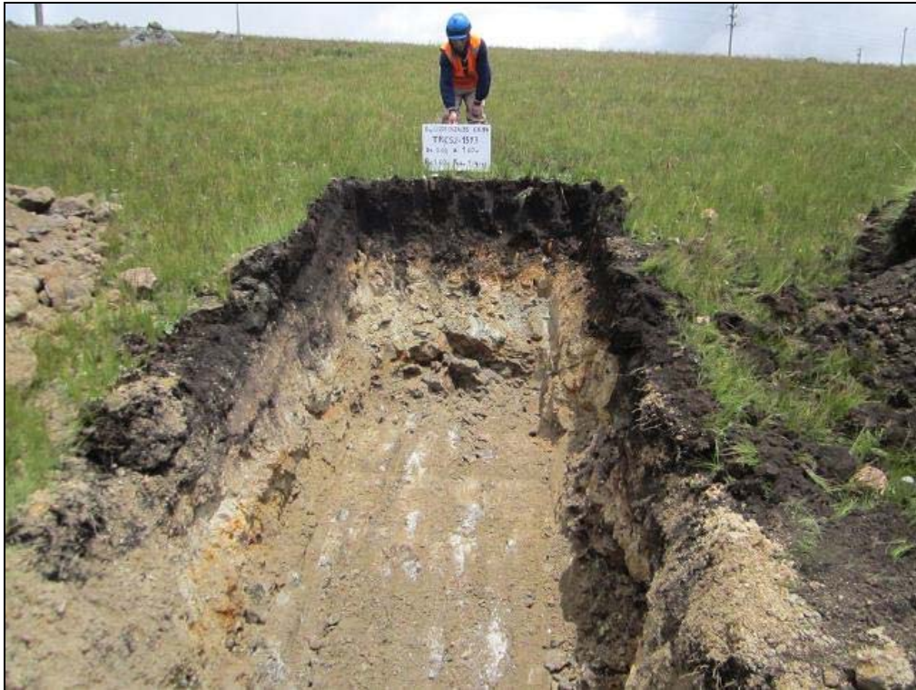
Fotografía 11: Calicata TP-CS2-1513, Profundidad 1.60 m.
