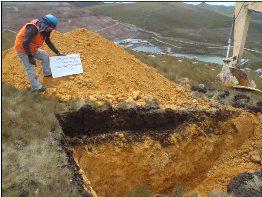
Fotografía 2: Material excavado de la calicata TP-CS2a-1529.
