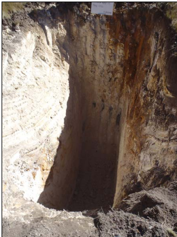
Fotografía 49: Calicata CCKPTP12-49, 4.90 m
