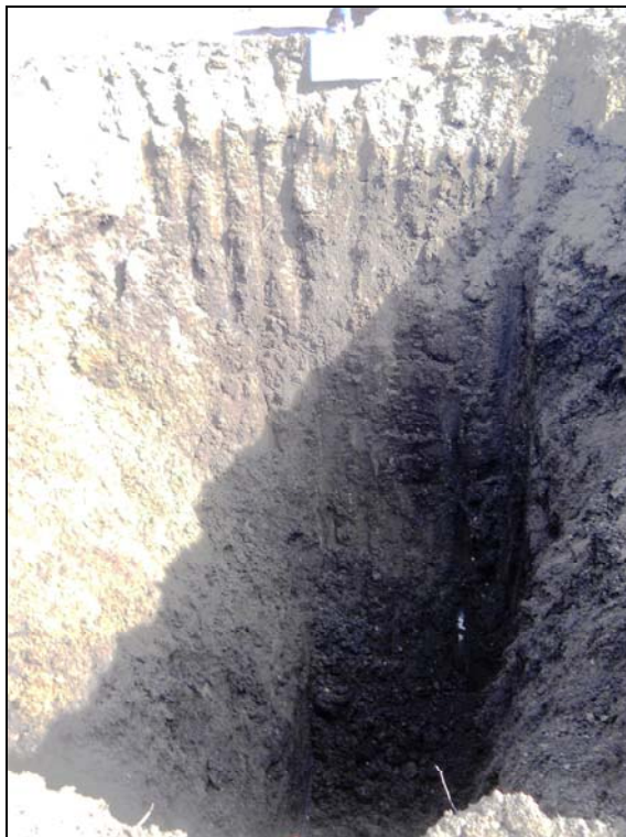
Fotografía 25: Calicata CCKPTP12-25, 5.60 m
