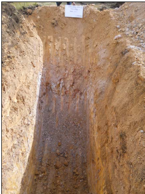
Fotografía 6: Calicata CCKPTP12-06, 3.70 m
