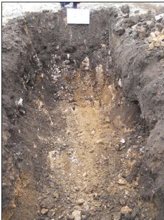
Fotografía 38: Calicata CCKPTP12-38, 2.00 m
