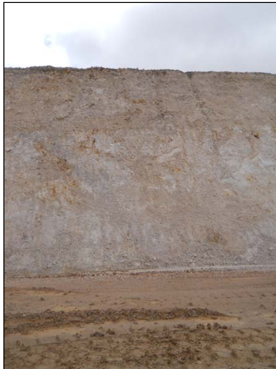
Fotografía 22: Calicata CCKPTP12-22, 6.50 m
