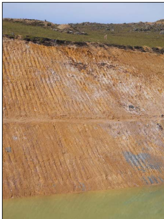
Fotografía 53: Calicata CCKPTP12-53, 6.50 m
