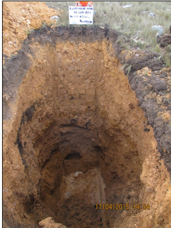
Fotografía 9: Calicata TP-CA14-1514, Profundidad 5.80 m.
