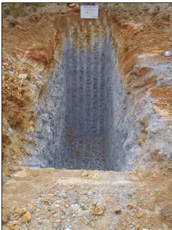
Fotografía 14: Calicata CCKPTP12-14, 4.00 m
