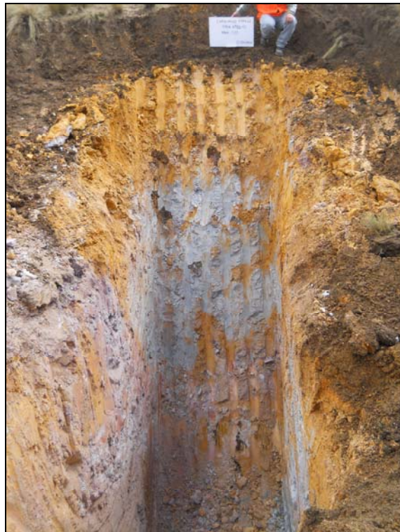
Fotografía 4: Calicata CCKPTP12-04, 4.80 m
