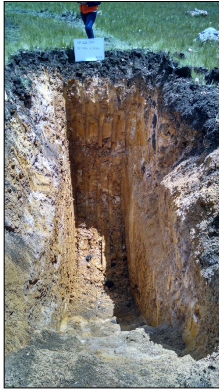
Fotografía 13: Calicata TP-CS2-1514, Profundidad 5.00 m.
