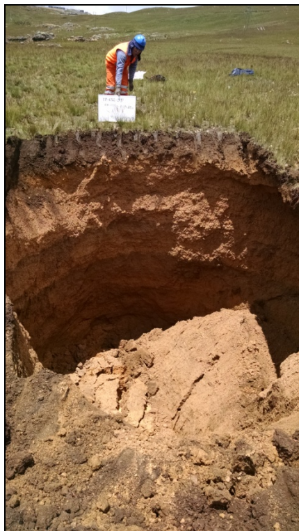
Fotografía 17: Calicata TP-CS2-1517, Profundidad 5.20 m.
