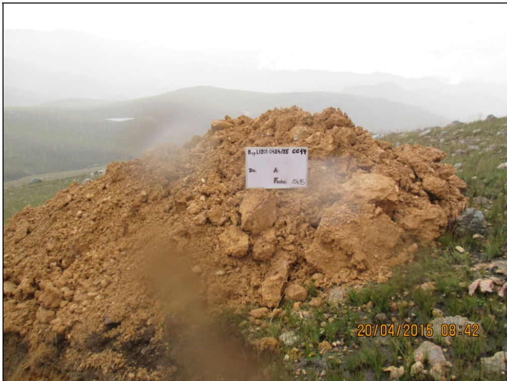
Fotografía 14: Material excavado de la calicata TP-CA14-1516.
