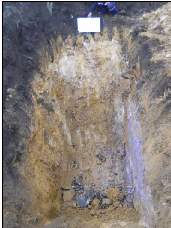
Fotografía 2: Calicata CCKPTP12-02, 3.10 m
