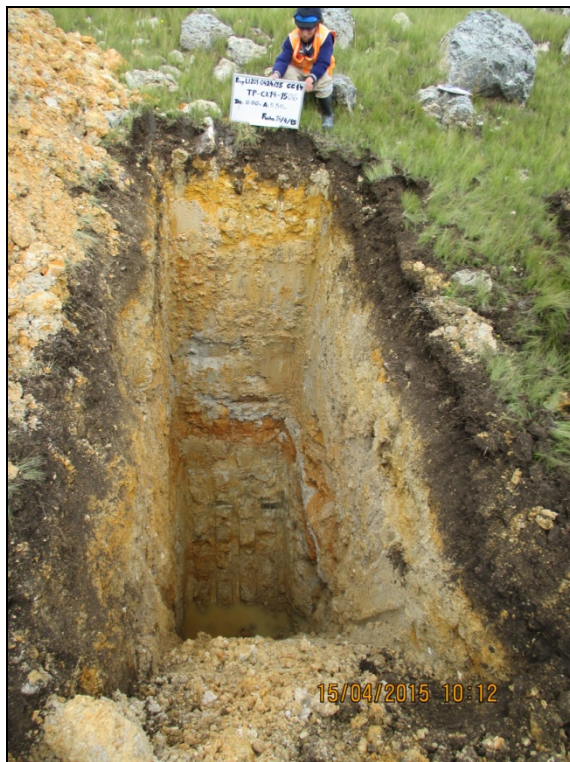
Fotografía 11: Calicata TP-CA14-1506, Profundidad 5.50 m.
