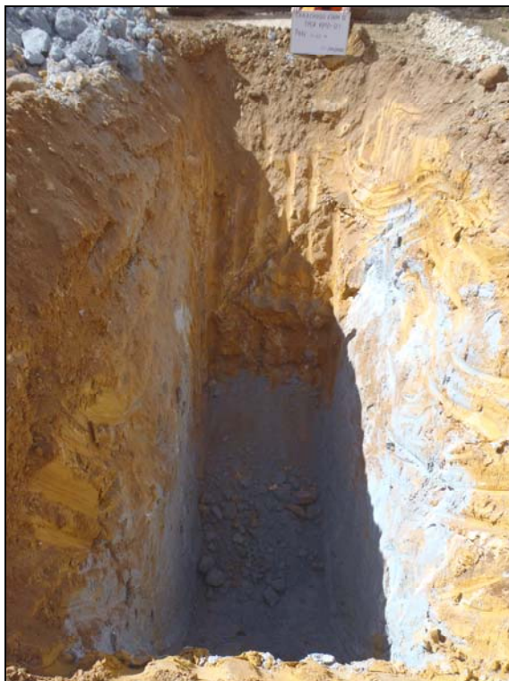
Fotografía 46: Calicata CCKPTP12-46, 4.60 m
