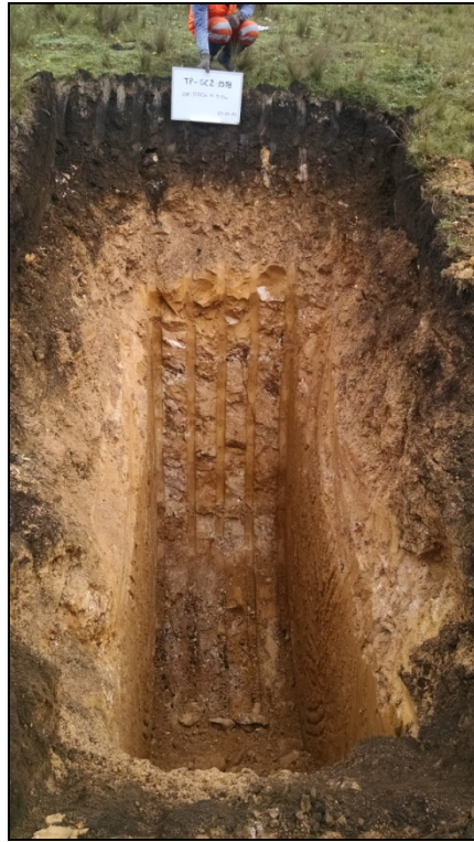
Fotografía 19: Calicata TP-CS2-1518, Profundidad 5.10 m.
