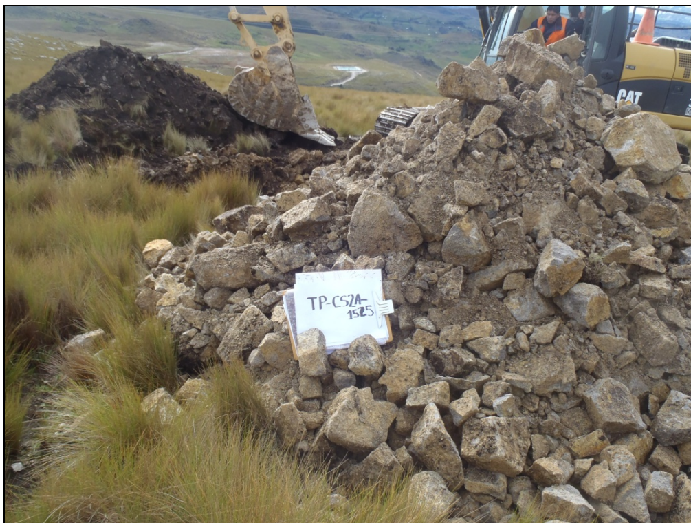
Fotografía 4: Material excavado de la calicata TP-CS2a-1525.
