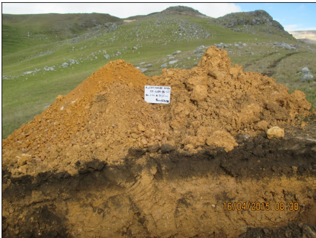
Fotografía 2: Material excavado de la calicata TP-CA14-1508.
