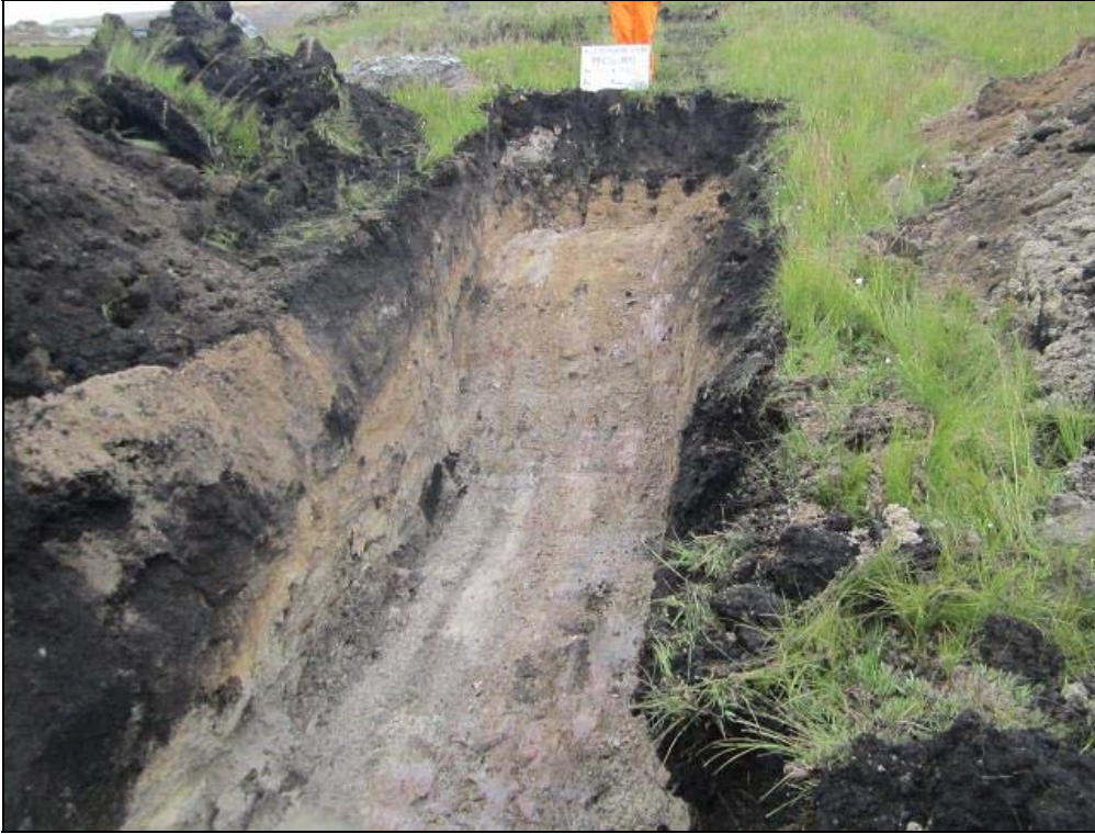
Fotografía 9: Calicata TP-CS2-1512, Profundidad 1.80 m.
