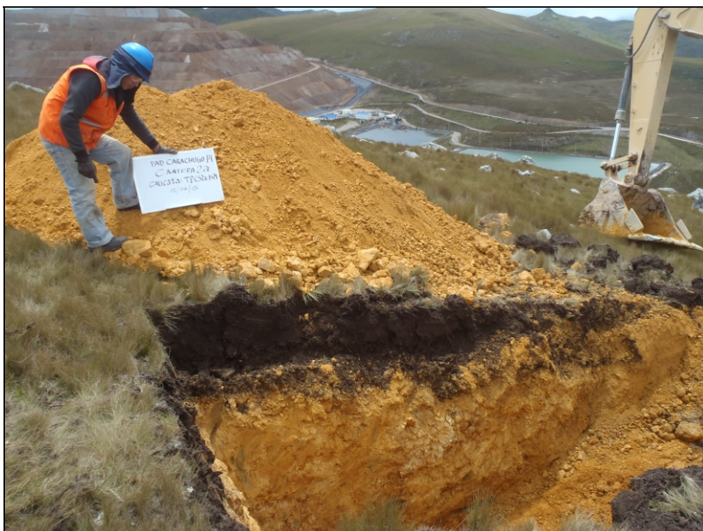
Fotografía 28: Material excavado de la calicata TP-CS2a-1529.
