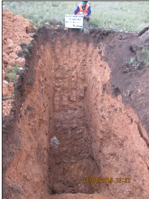
Fotografía 11: Calicata TP-CA14-1515, Profundidad 5.60 m.
