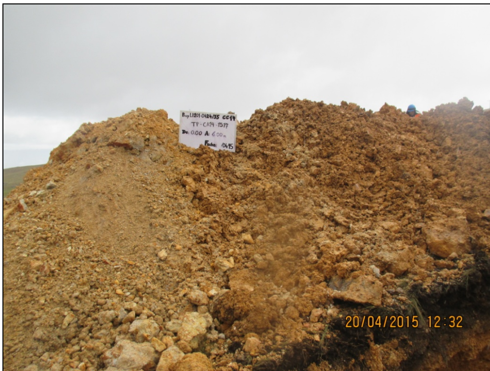
Fotografía 16: Material excavado de la calicata TP-CA14-1517.
