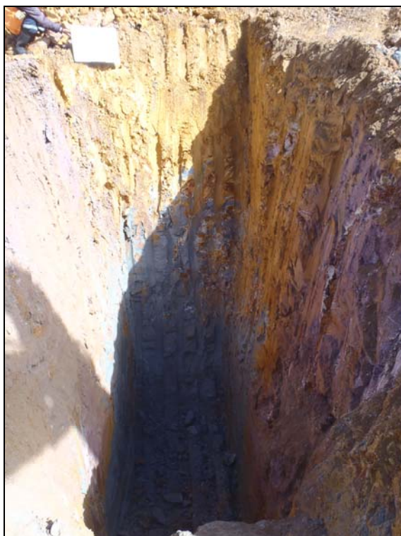
Fotografía 10: Calicata CCKPTP12-10, 5.20 m
