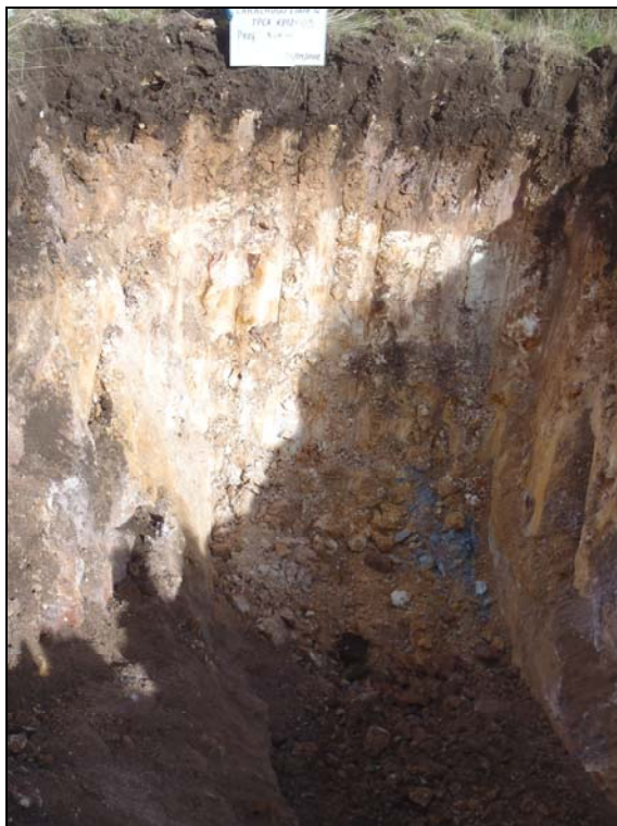
Fotografía 34: Calicata CCKPTP12-34, 3.20 m
