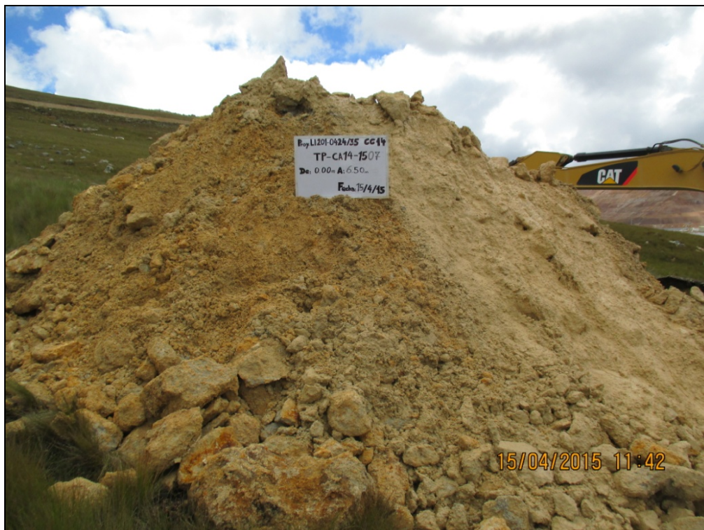
Fotografía 14: Material excavado de la calicata TP-CA14-1507.
