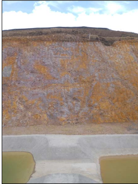
Fotografía 3: Calicata CCKPTP12-03, 5.10 m
