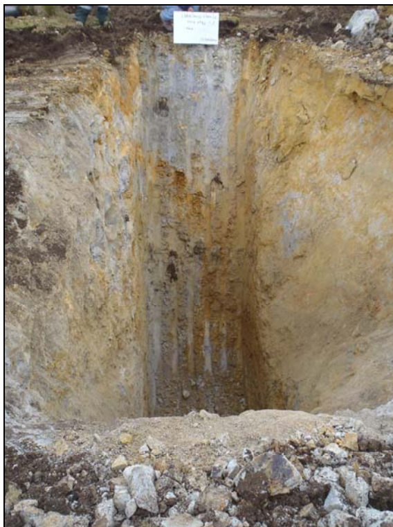
Fotografía 16: Calicata CCKPTP12-16, 5.00 m
