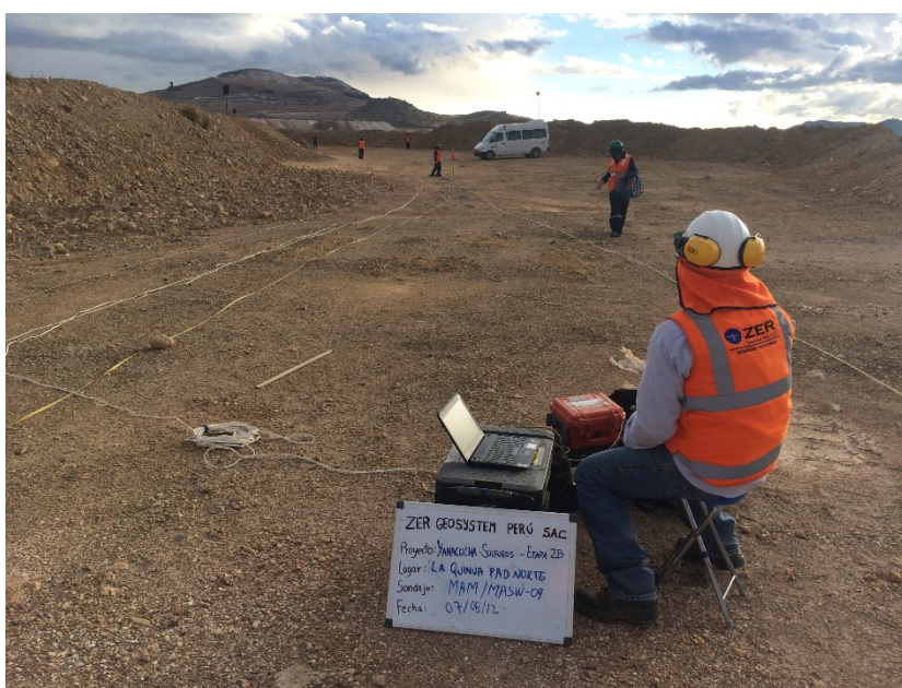
Fotografía 18: Vista panorámica de la zona de trabajo donde se realizó el ensayo sísmico MASW-09. Se observa el tendido del cable trigger, geófonos y el accionar de la comba propia del ensayo.
