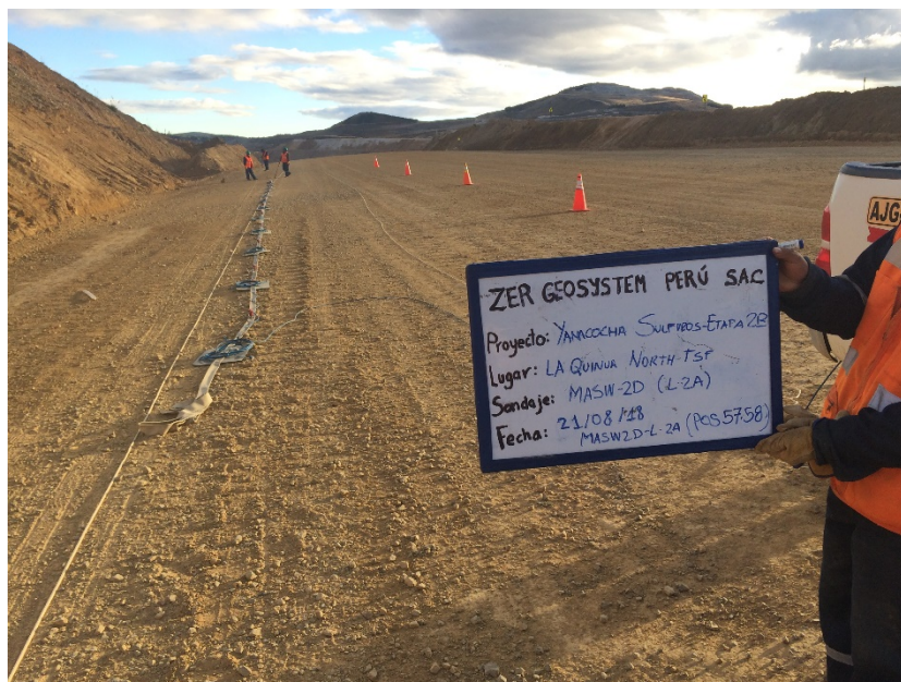
Fotografía 34: Vista panorámica de la zona de trabajo donde se realizó el ensayo sísmico MASW-2D. Se aprecia una faja unida al cable de refracción sísmica y los geófonos. En la fotografía se muestra las posiciones del 57 - 58 del presente ensayo.
