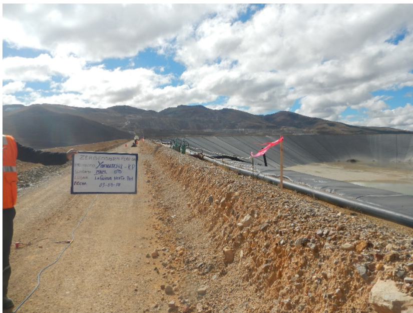
Fotografía 03: Vista panorámica de la zona de trabajo donde se realizó el ensayo sísmico MAM-03. Se observa el tendido del cable de refracción sísmica, una soga con medidas de ensayos y los geófonos. Asimismo, se aprecia una estaca con una cinta rosa la cual indica el punto el cual no ha sido replanteado.
