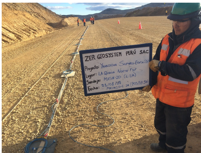
Fotografía 33: Vista panorámica de la zona de trabajo donde se realizó el ensayo sísmico MASW-2D. Se aprecia una faja unida al cable de refracción sísmica y los geófonos. En la fotografía se muestra las posiciones del 53 - 56 del presente ensayo.
