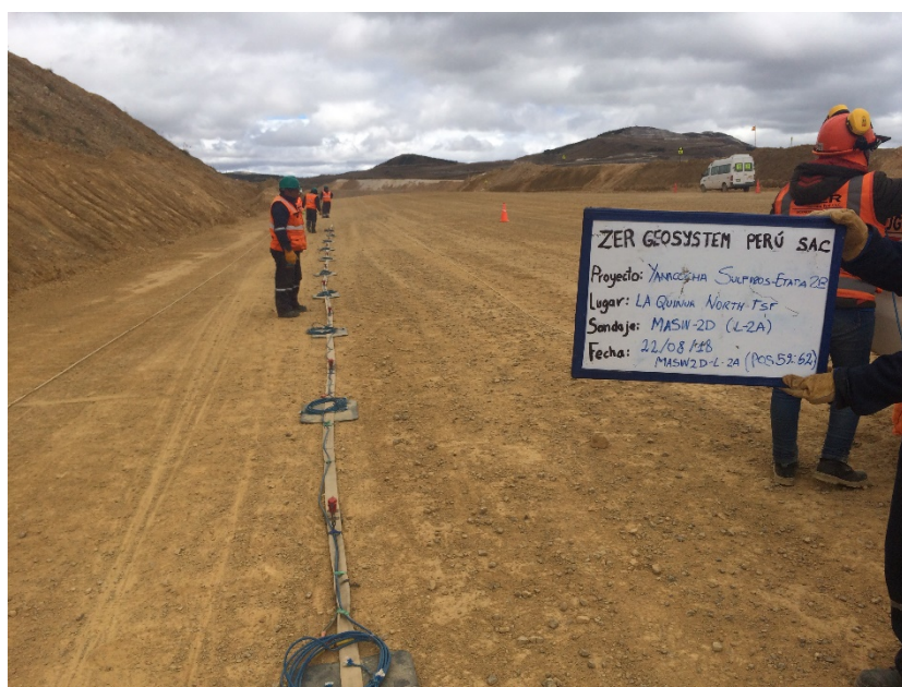
Fotografía 35: Vista panorámica de la zona de trabajo donde se realizó el ensayo sísmico MASW-2D. Se aprecia una faja unida al cable de refracción sísmica y los geófonos. En la fotografía se muestra las posiciones del 59 - 62 del presente ensayo.
