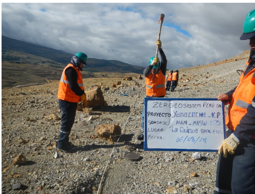
Fotografía 06: Vista panorámica de la zona de trabajo donde se realizó el ensayo sísmico MASW-03. Se observa el tendido del cable trigger, geófonos y el accionar de la comba propia del ensayo.
