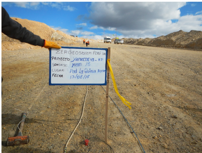
Fotografía 18: Vista panorámica de la zona de trabajo donde se realizó el ensayo sísmico MAM-18. Se observa el tendido del cable de refracción sísmica, una soga con medidas de ensayos y los geófonos. Asimismo, se aprecia una estaca con una cinta amarilla la cual indica el punto el cual ha sido replanteado.
