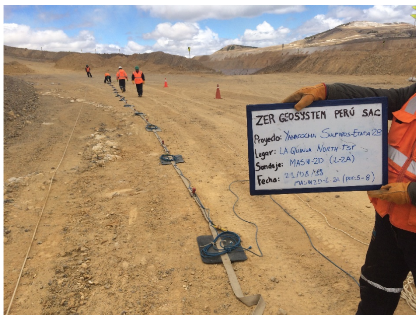
Fotografía 21: Vista panorámica de la zona de trabajo donde se realizó el ensayo sísmico MASW-2D. Se aprecia una faja unida al cable de refracción sísmica y los geófonos. En la fotografía se muestra las posiciones del 5 - 8 del presente ensayo.
