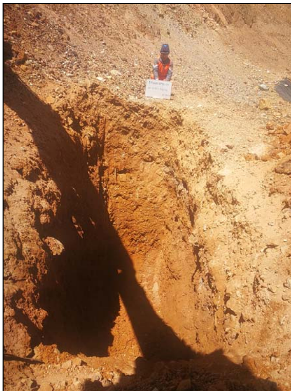
Fotografía 9: Calicata TPLQN KP18-05 Profundidad 4,60 m.
