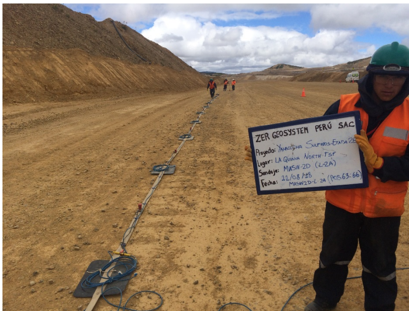
Fotografía 36: Vista panorámica de la zona de trabajo donde se realizó el ensayo sísmico MASW-2D. Se aprecia una faja unida al cable de refracción sísmica y los geófonos. En la fotografía se muestra las posiciones del 63 - 66 del presente ensayo.
