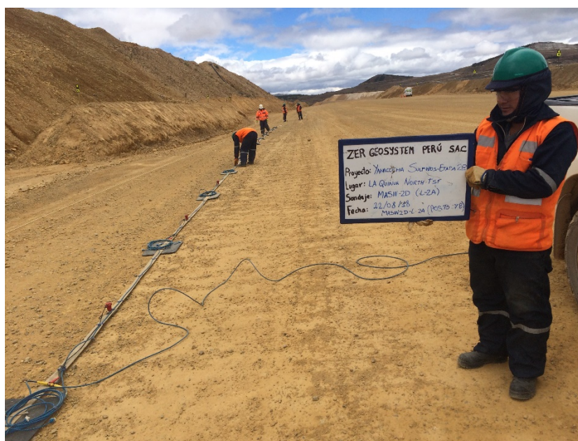
Fotografía 39: Vista panorámica de la zona de trabajo donde se realizó el ensayo sísmico MASW-2D. Se aprecia una faja unida al cable de refracción sísmica y los geófonos. En la fotografía se muestra las posiciones del 75 - 78 del presente ensayo.
