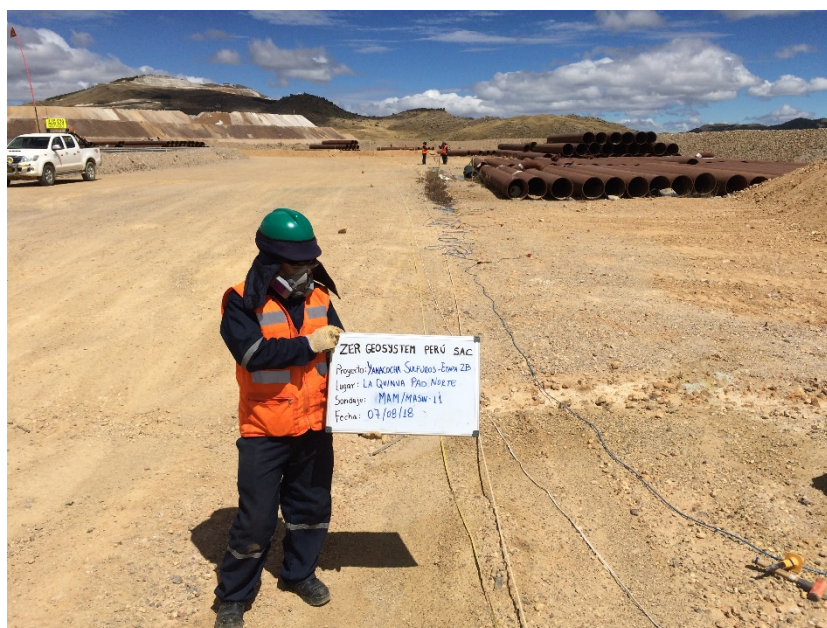
Fotografía 22: Vista panorámica de la zona de trabajo donde se realizó el ensayo sísmico MASW-11. Se observa el tendido del cable trigger, geófonos y la comba propia del ensayo.
