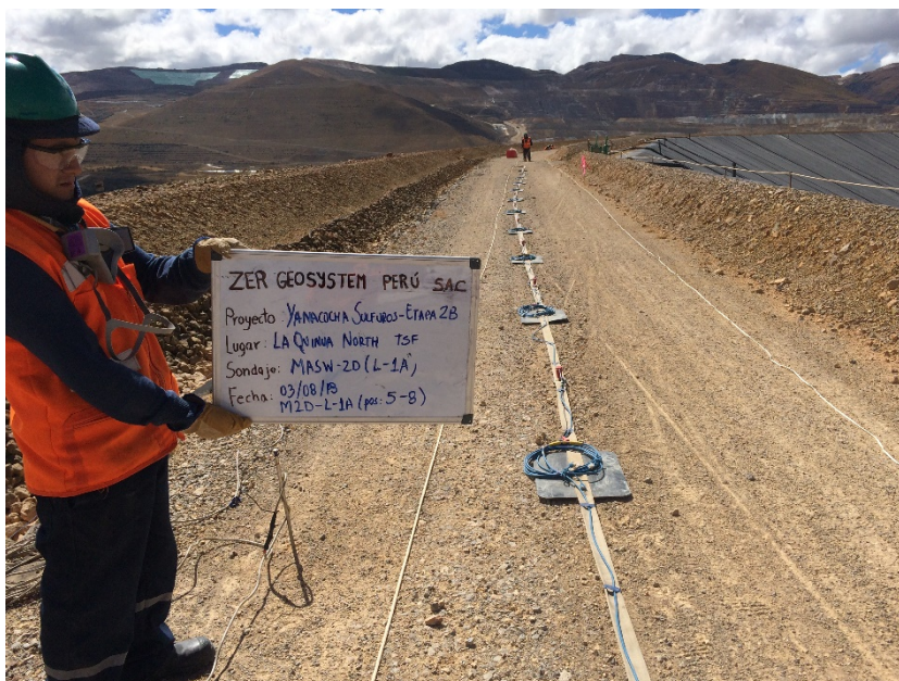
Fotografía 02: Vista panorámica de la zona de trabajo donde se realizó el ensayo sísmico MASW-2D. Se aprecia una faja unida al cable de refracción sísmica y los geófonos. En la fotografía se muestra las posiciones del 05 - 08 del presente ensayo.
