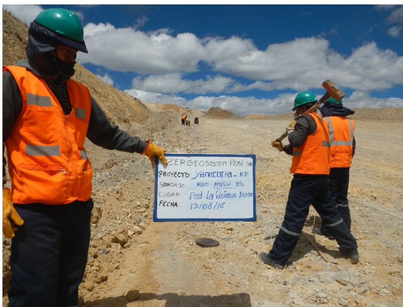
Fotografía 12: Vista panorámica de la zona de trabajo donde se realizó el ensayo sísmico MASW-06. Se observa el tendido del cable trigger, geófonos y el accionar de la comba propia del ensayo.
