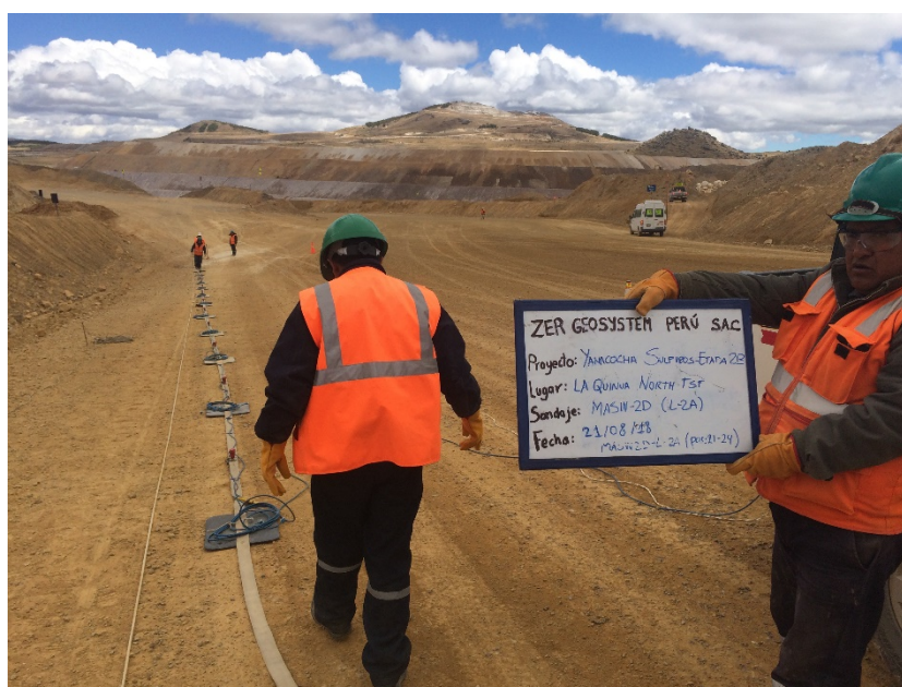
Fotografía 25: Vista panorámica de la zona de trabajo donde se realizó el ensayo sísmico MASW-2D. Se aprecia una faja unida al cable de refracción sísmica y los geófonos. En la fotografía se muestra las posiciones del 21 - 24 del presente ensayo.
