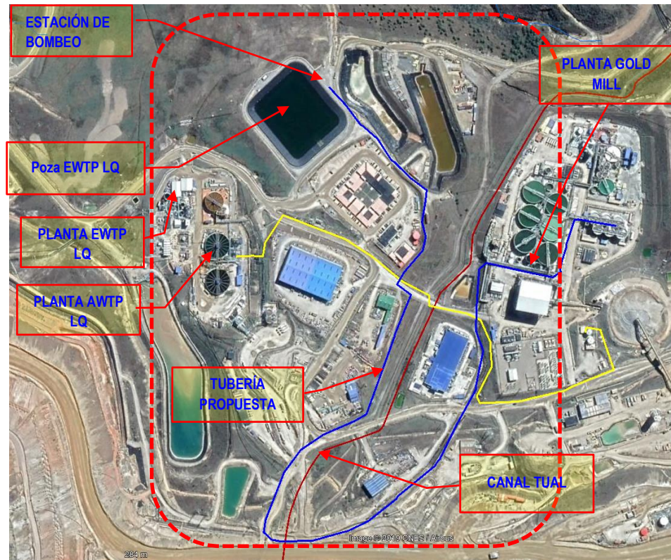
Figura N° 2: Sistema de bombeo de agua tratada poza EWTP LQ a Gold Mill
