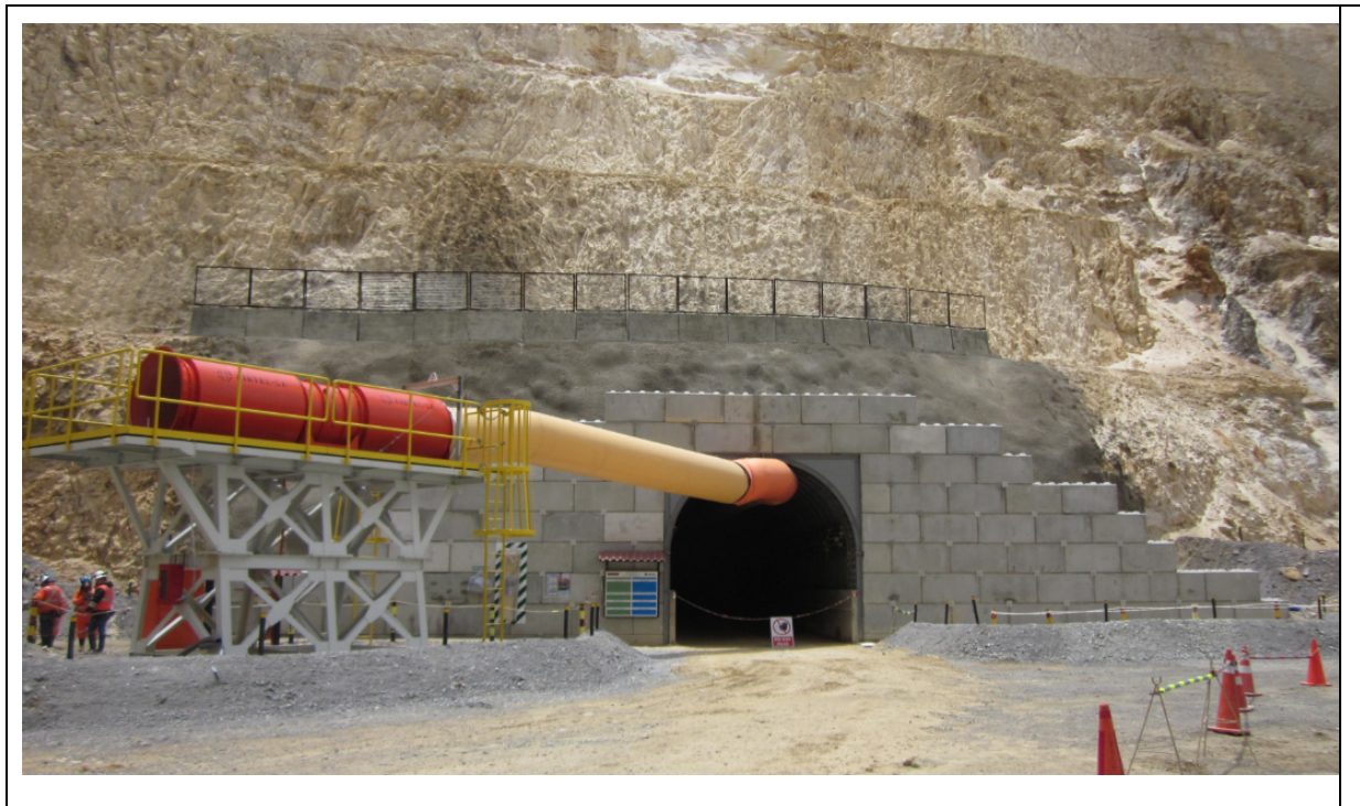
Figura 11 Segundo Portal (Nivel 3800)
