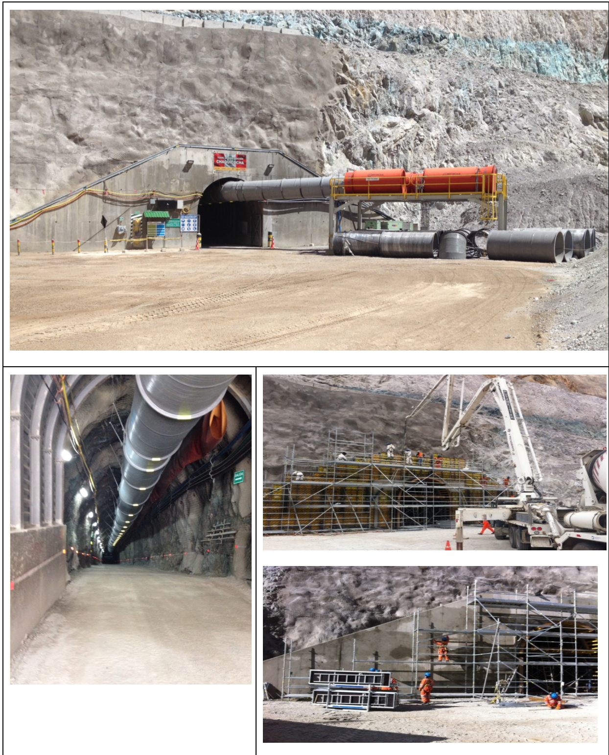
Figura 22 Portal 1, Túnel 3750, Ejecutado 2015
