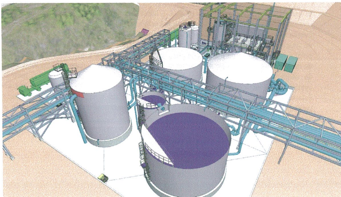
Figura 1-21: La Quinoa Oeste – Extracción por solventes (tratamiento de borras y playa de tanques)
