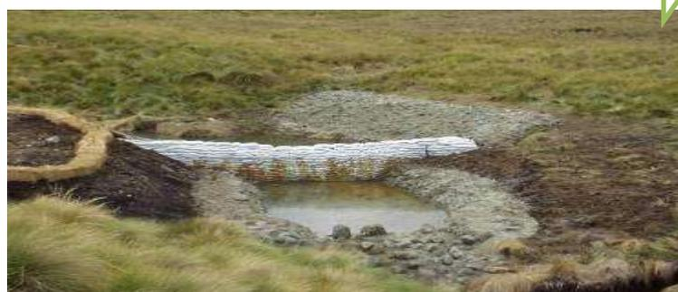
**Foto 19** Estructuras de sacos polietileno con concreto
