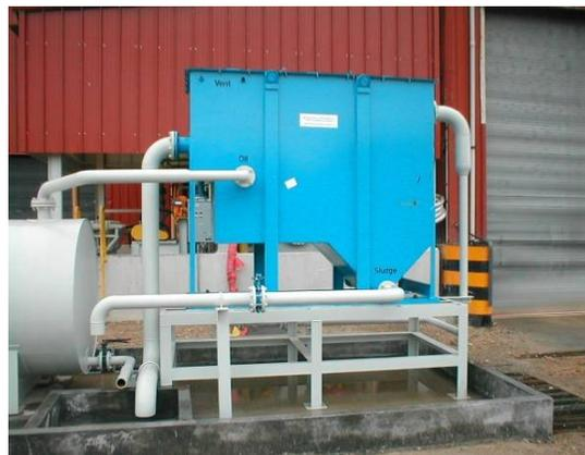
**Figura N° 4** Sistema separador de hidrocarburo (trampa de hidrocarburos).
