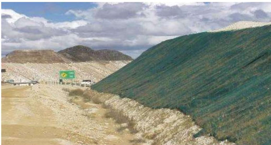
**Foto 18** Mantas para el control de la erosión
