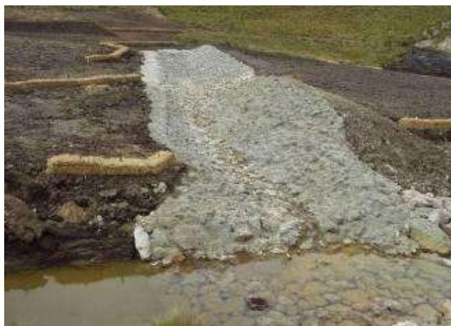
**Foto 12** Canal con rip-rap con lechada de concreto
