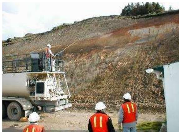
Foto 17 Hidrosembrado (hidráulico) de un talud del camino
