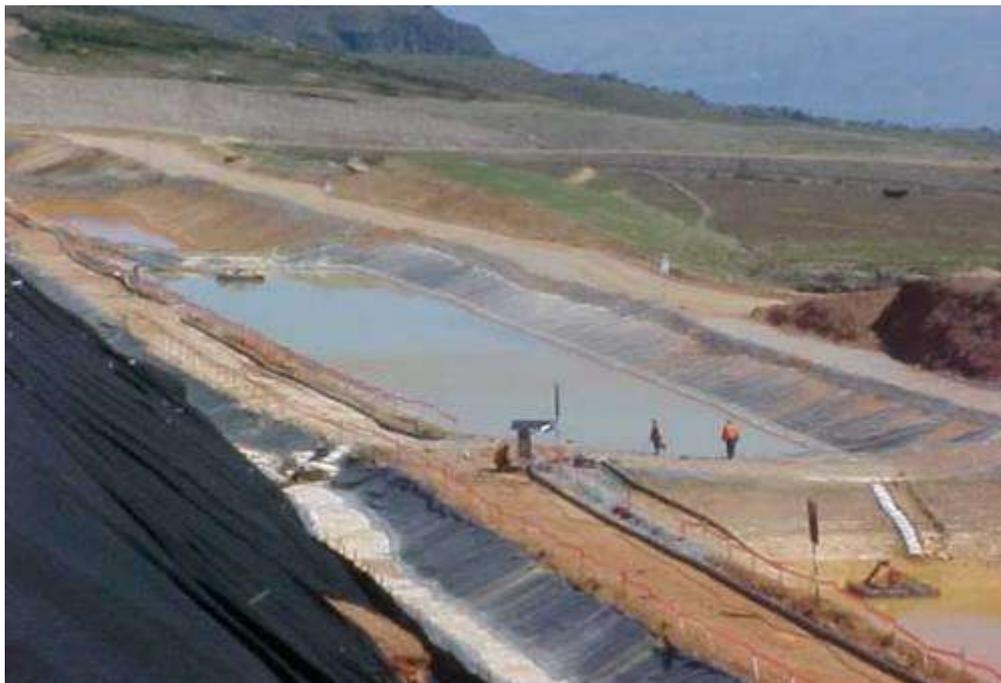
**Foto 9** BMP de poza de control de sedimentos en la desembocadura de drenaje del tajo
