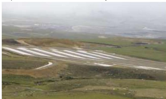
**Foto 4** BMP de control de sedimentos intermedios – Serpentina Multi-celdas
