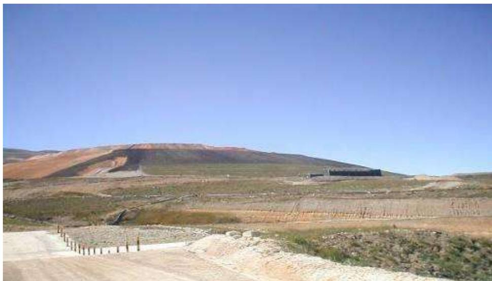
**Foto 11** Restauración progresiva de un depósito de desmonte.
