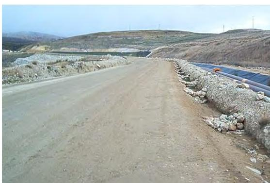
**Figura N° 3** Vías de servicio con drenaje adecuado.
