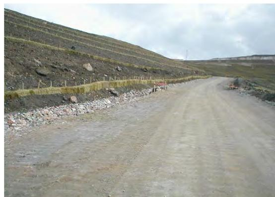
**Figura N° 2** Vía con drenaje adecuado y taludes restaurados.
