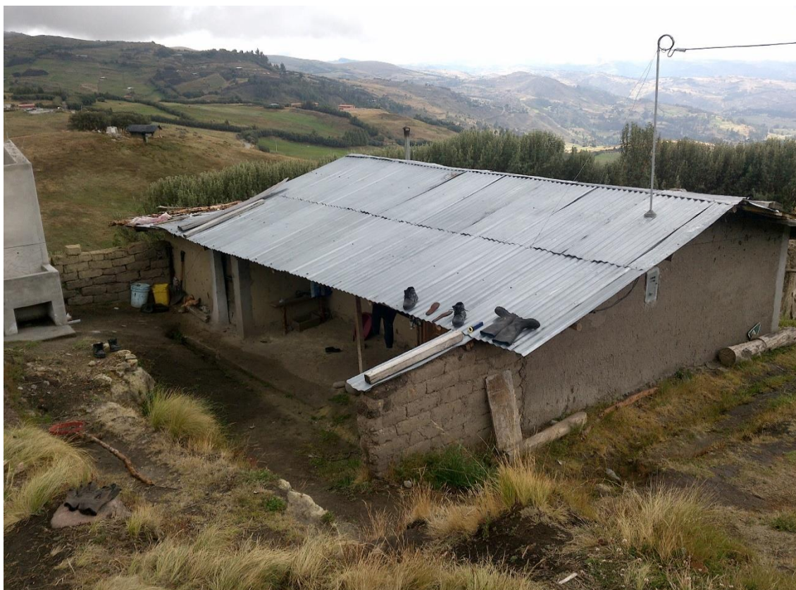
Características constructivas de la vivienda del caserío Pabellón de Combayo
