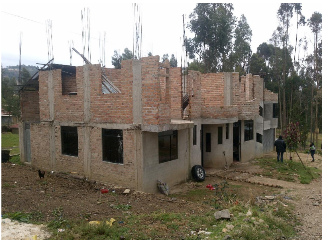
Características constructivas de la vivienda del caserío Cochapampa
