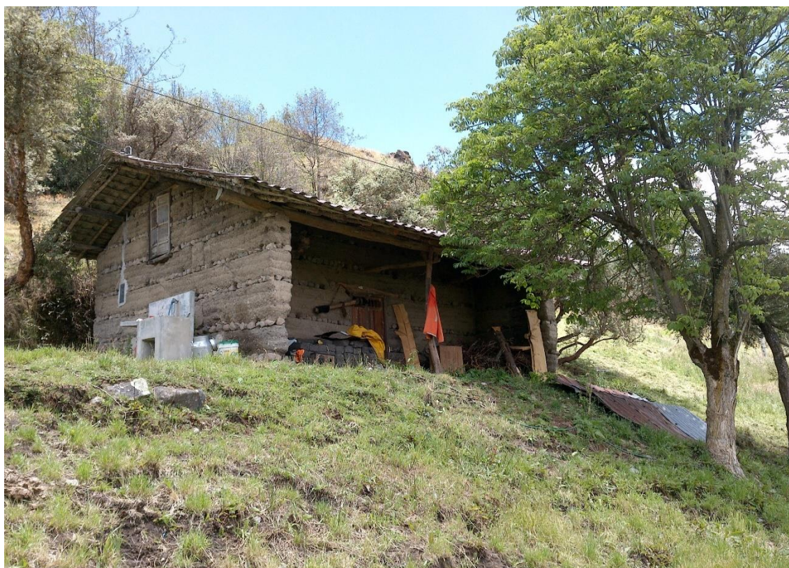
Características constructivas de la vivienda del caserío Purhuay Alto
