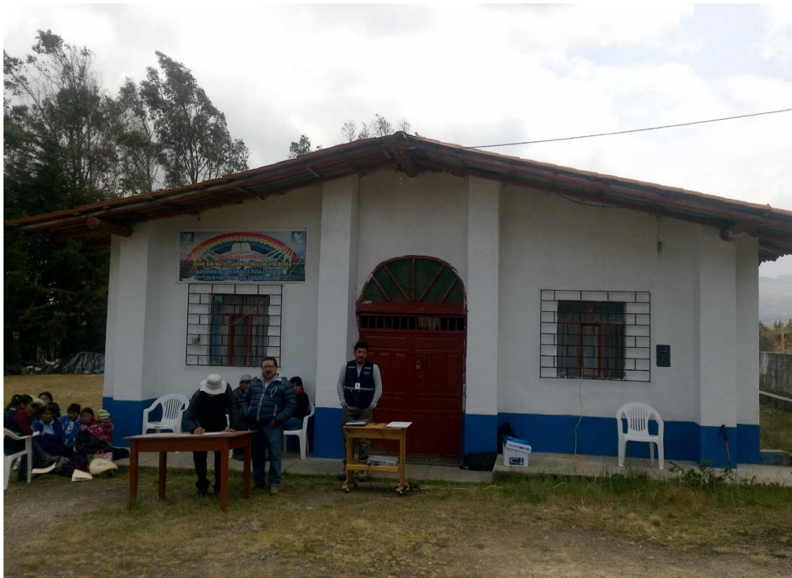
Iglesia del caserío Cince Las Vizcachas
