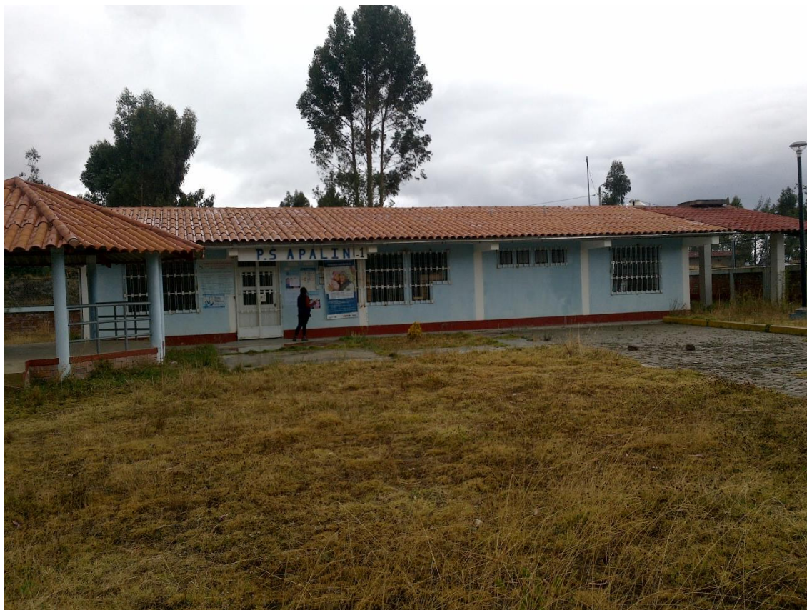
Puesto de Salud del caserío Apalín
