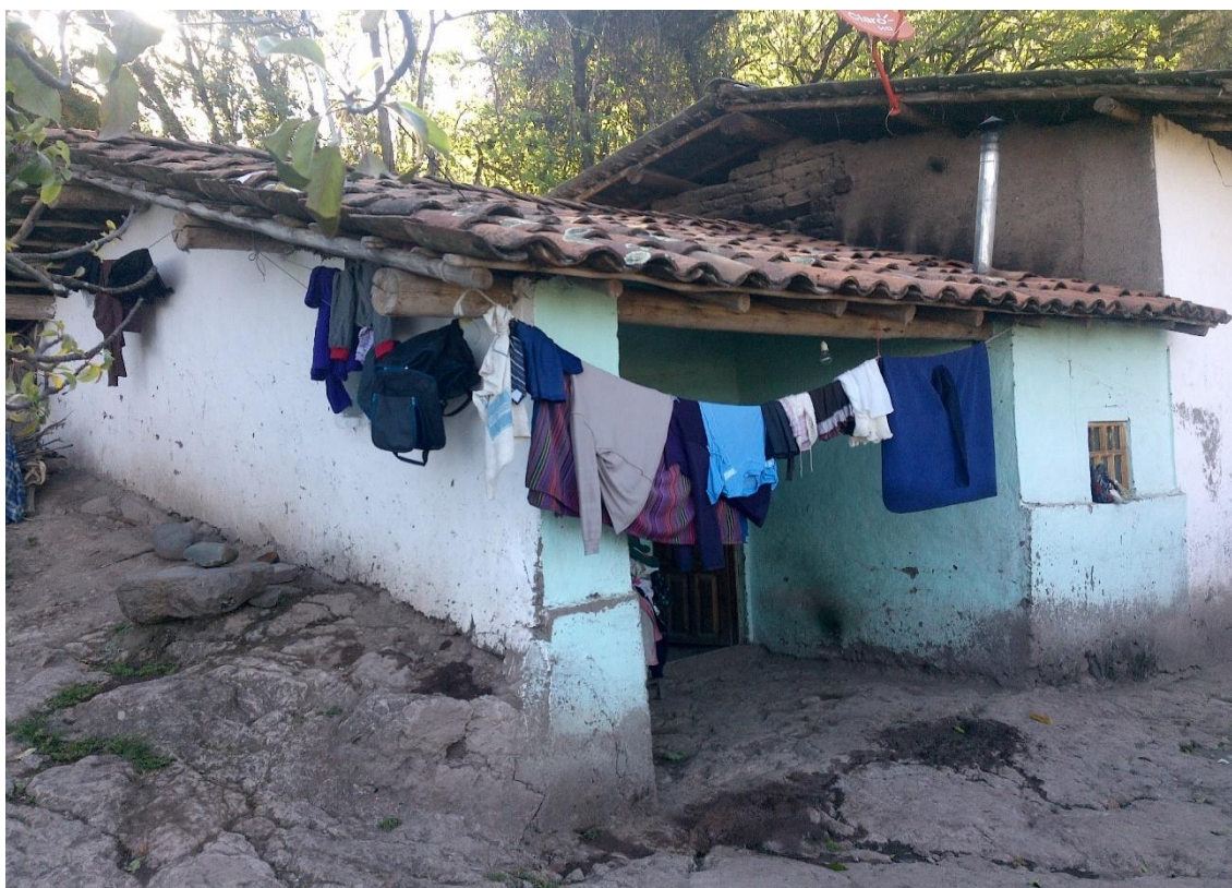
Características constructivas de la vivienda del caserío Suoporcón
