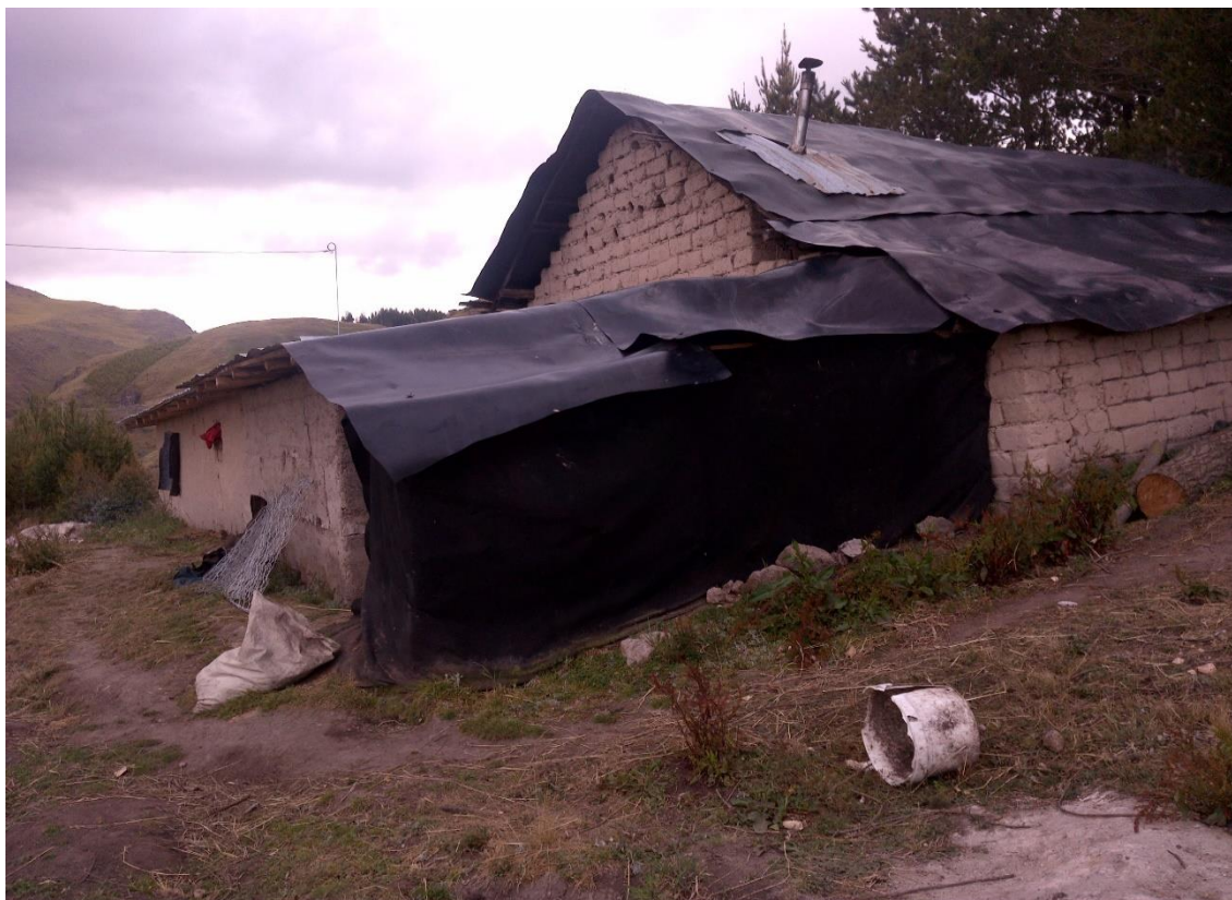
Características constructivas de la vivienda del caserío El Porvenir de Combayo
