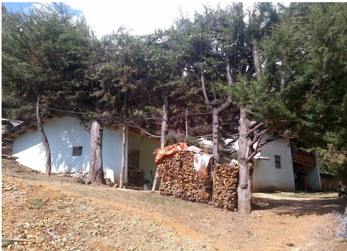
Características constructivas de la vivienda del caserío La Ramada
