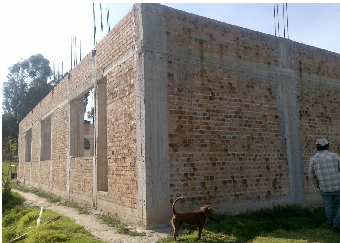
Características constructivas de la vivienda del caserío Huambocancha Chica
