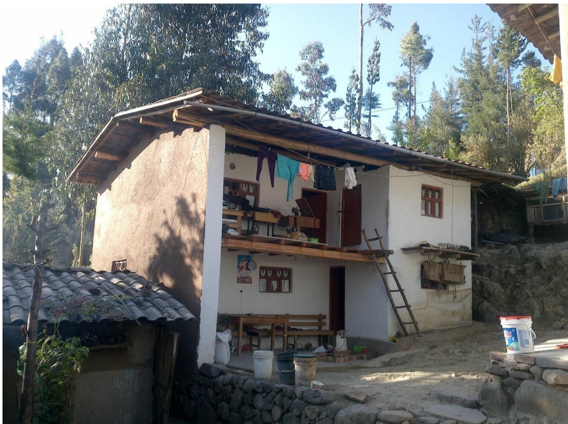
Características constructivas de la vivienda del caserío Chaupimayo
