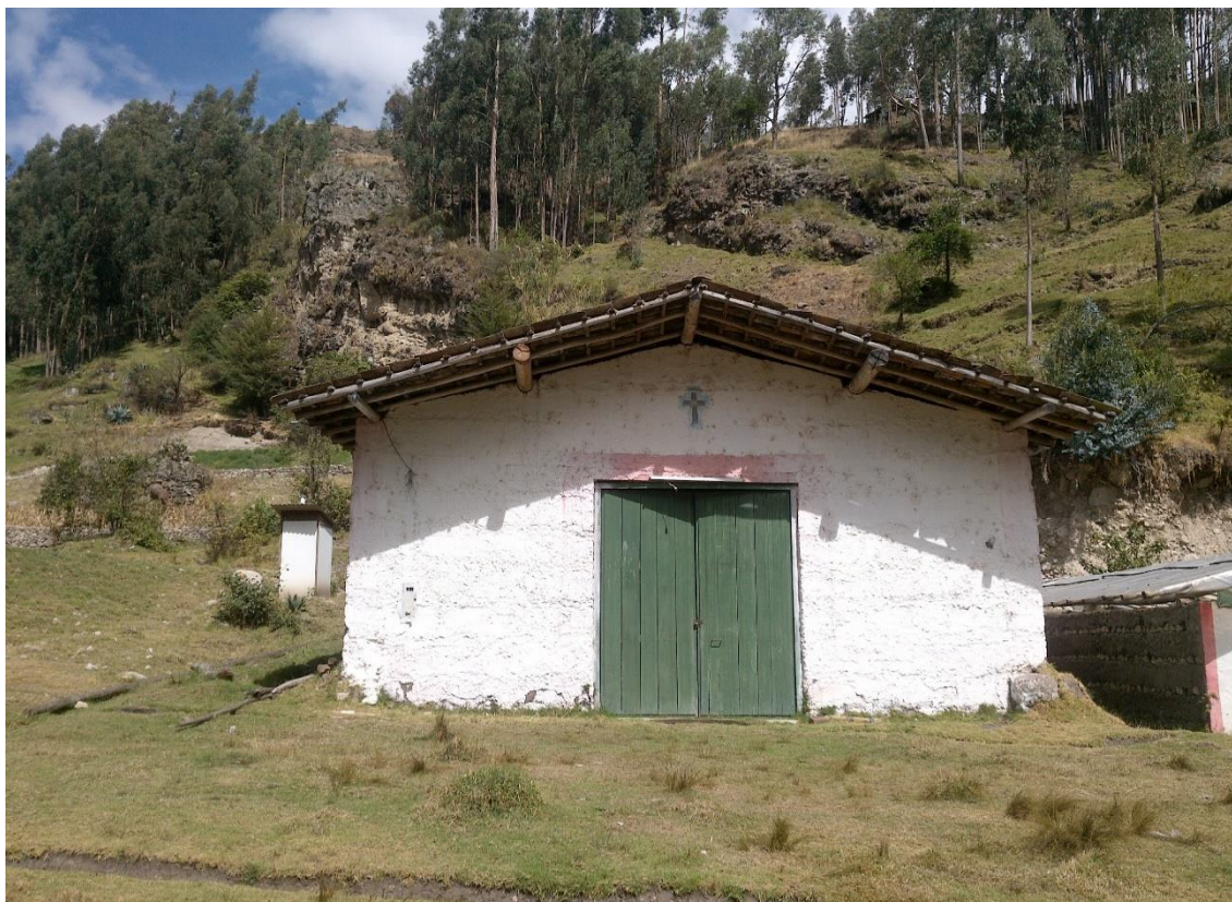
Características constructivas de la vivienda del caserío Llushcapampa Baja
