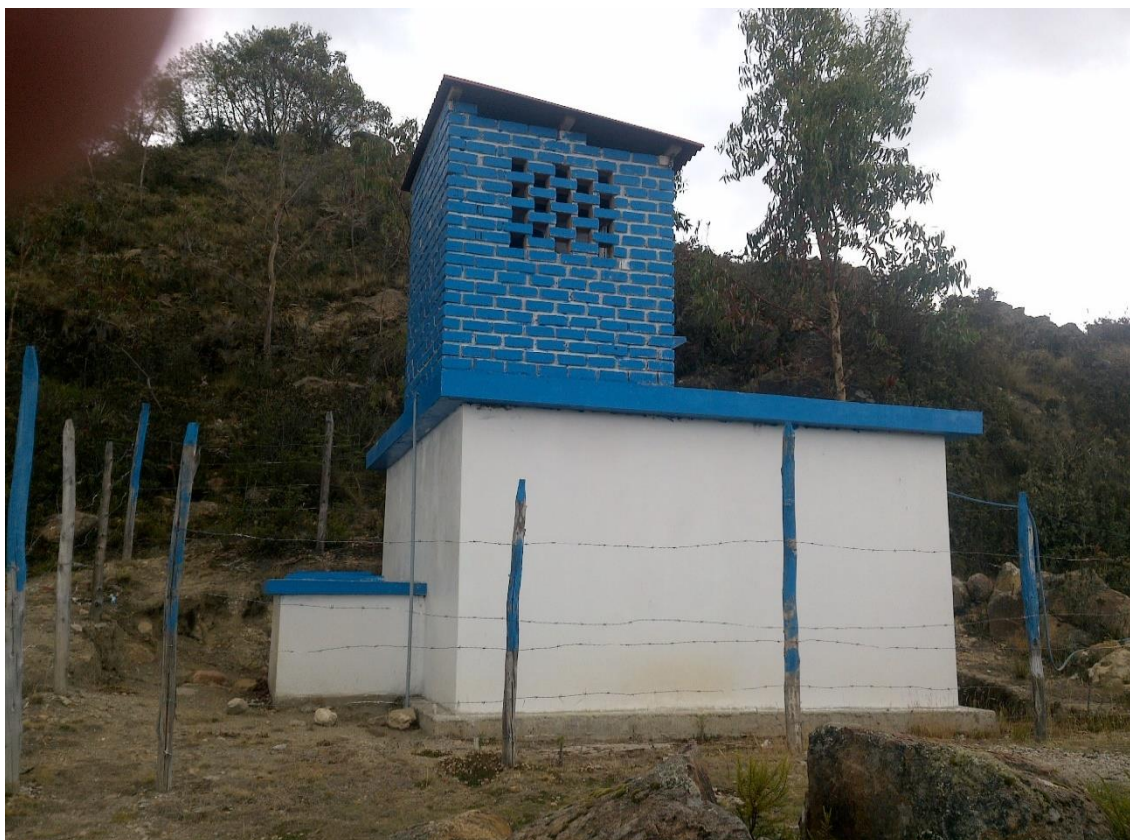
Captación del SAP del caserío Bellavista Alta
