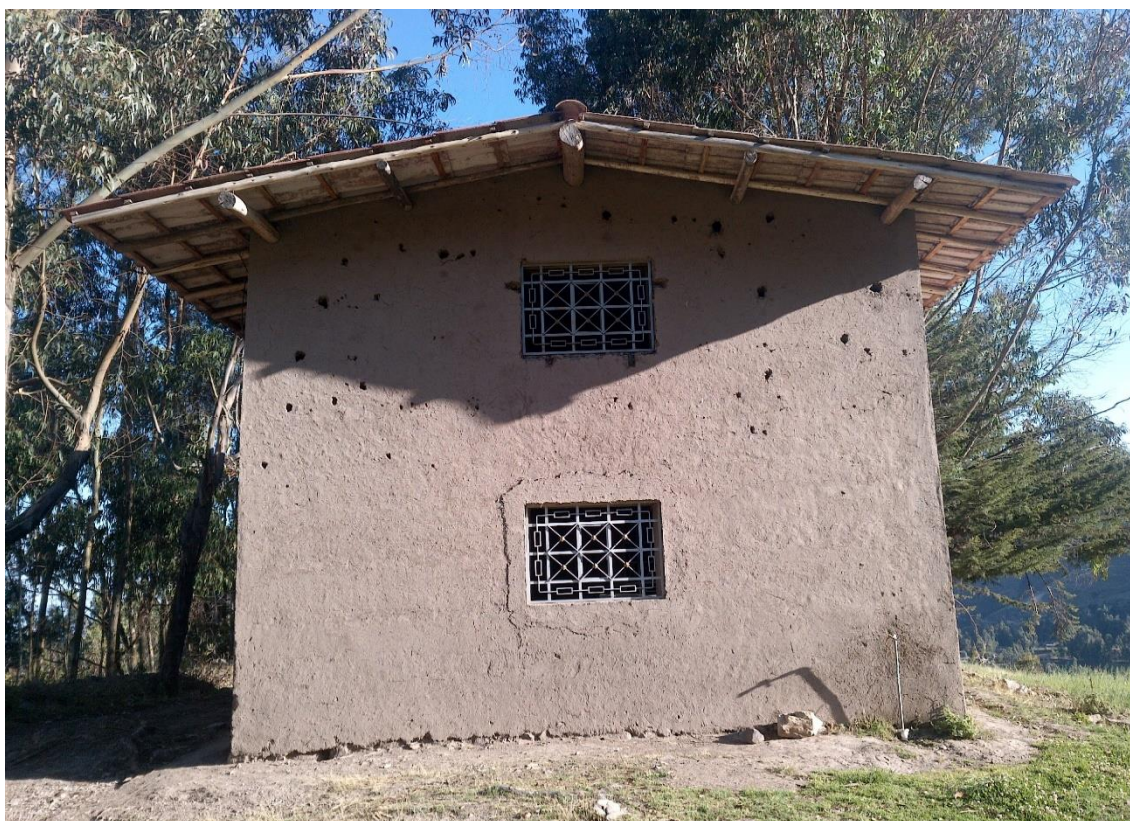
Características constructivas de la vivienda del caserío Suoporcón
