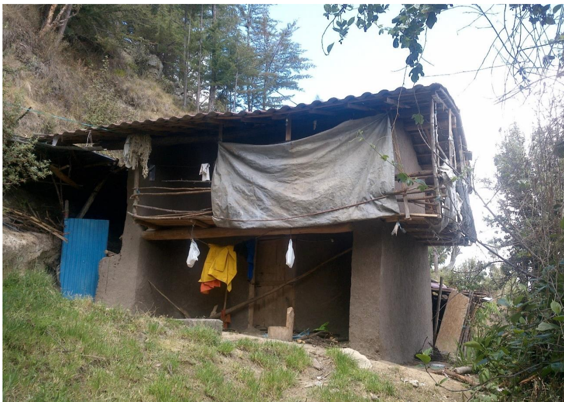
Características constructivas de la vivienda del caserío Yun Yun Bajo
