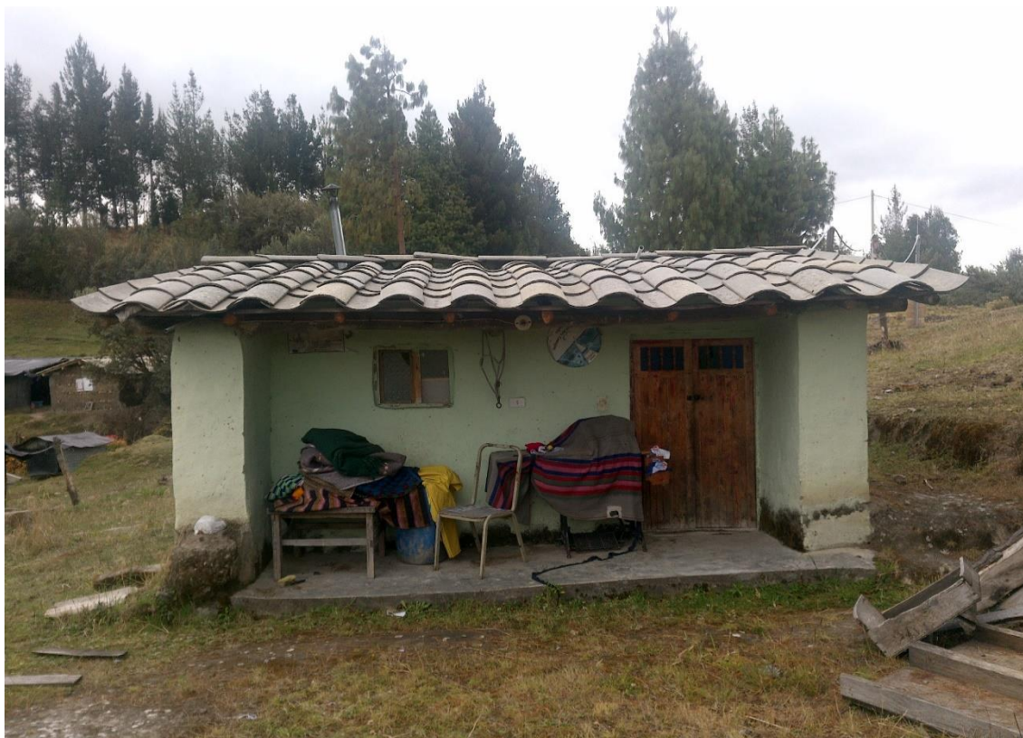
Características constructivas de la vivienda del caserío Tual
