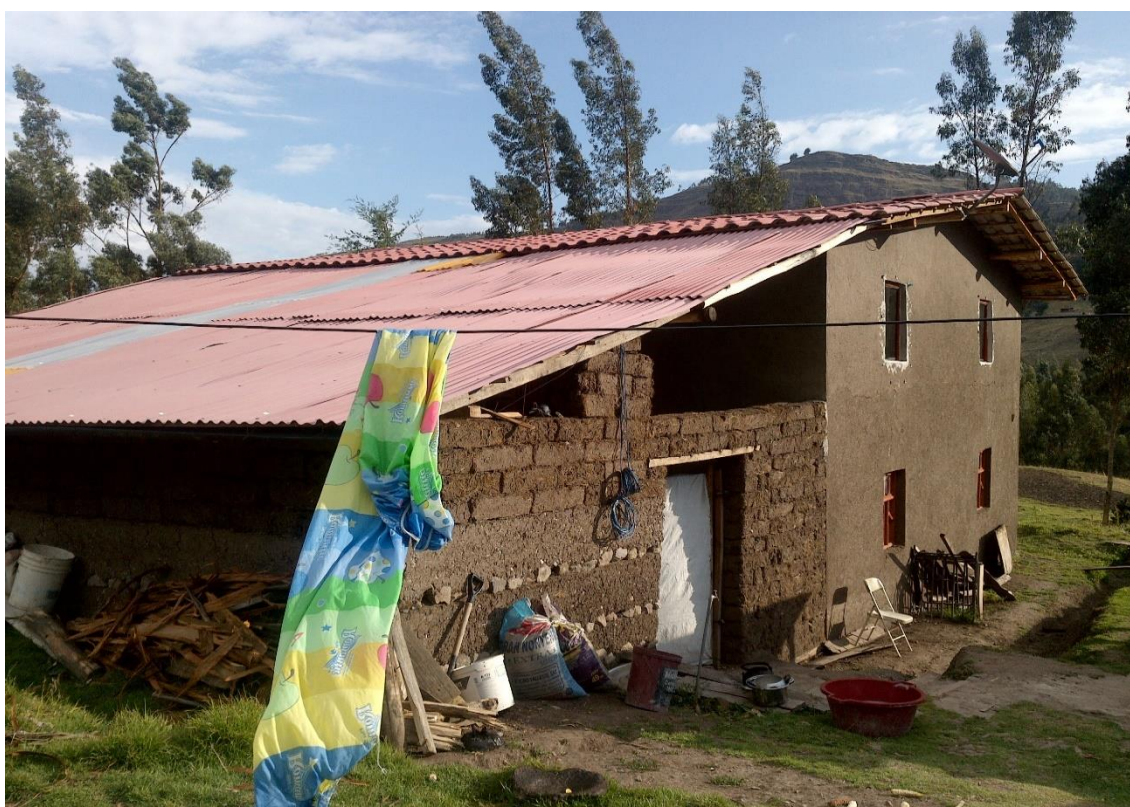
Características constructivas de la vivienda del caserío Santa Rosa
