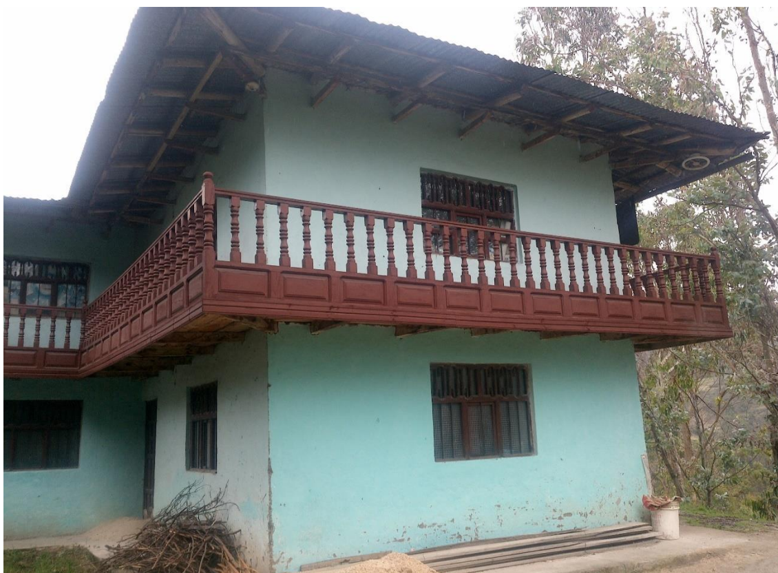
Características constructivas de la vivienda del caserío San Pedro
