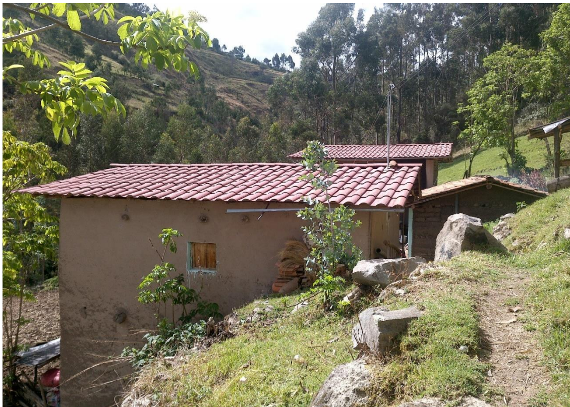
Características constructivas de la vivienda del caserío Coñor
