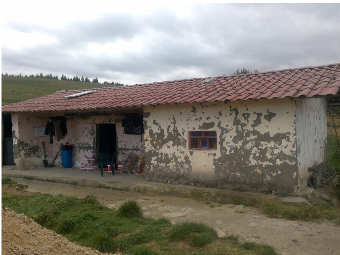
Características constructivas de la vivienda del caserío La Apalina
