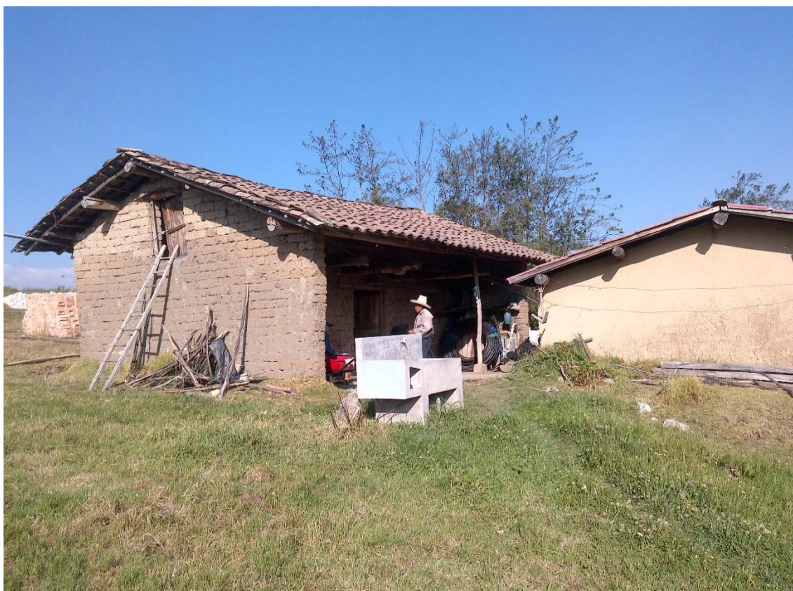
Características constructivas de la vivienda del caserío Barrojo
