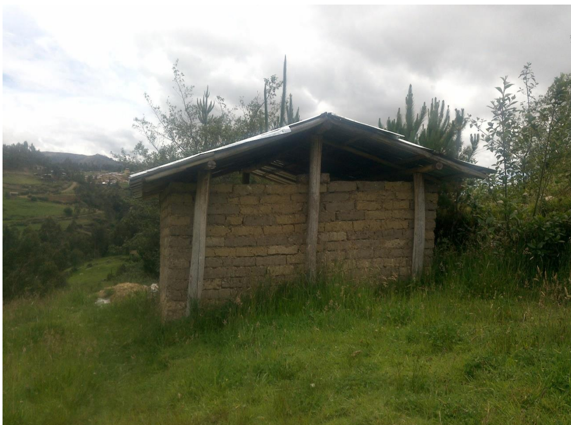
Características constructivas de la vivienda del caserío El Triunfo
