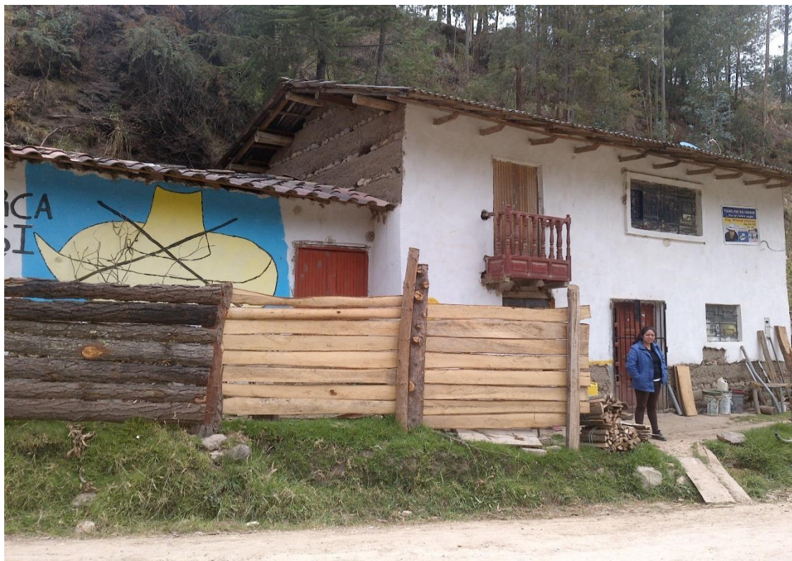
Características constructivas de la vivienda del caserío Llushcapampa Baja
