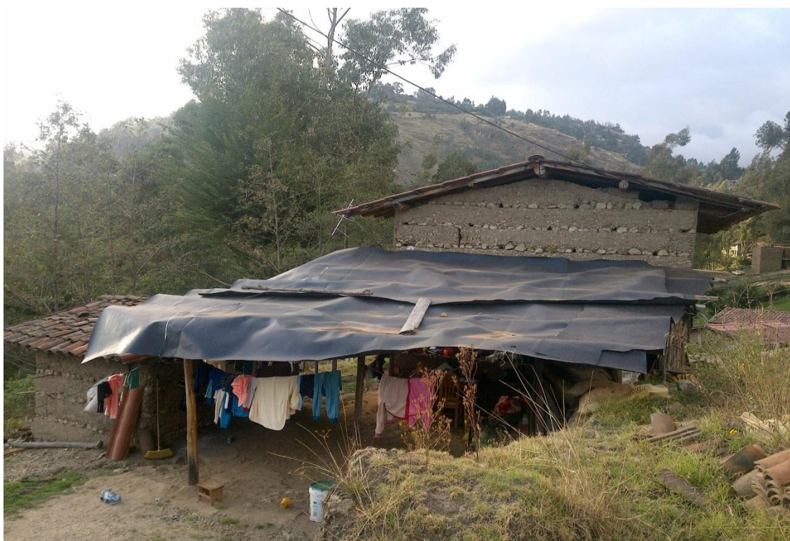
Características constructivas de la vivienda del caserío Coñor
