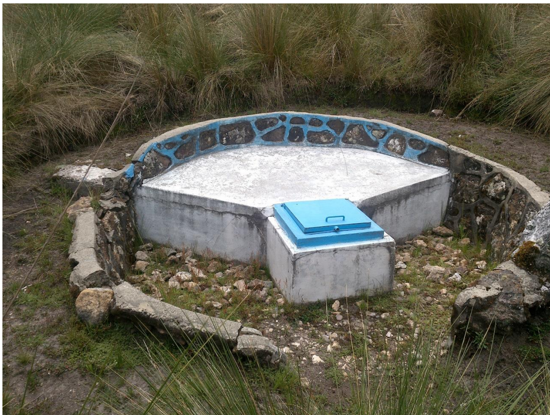
Cámara rompedor de presión del caserío Chilimpampa Alta
