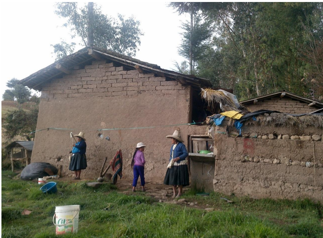
Características constructivas de la vivienda del caserío Manzanitas Capellania
