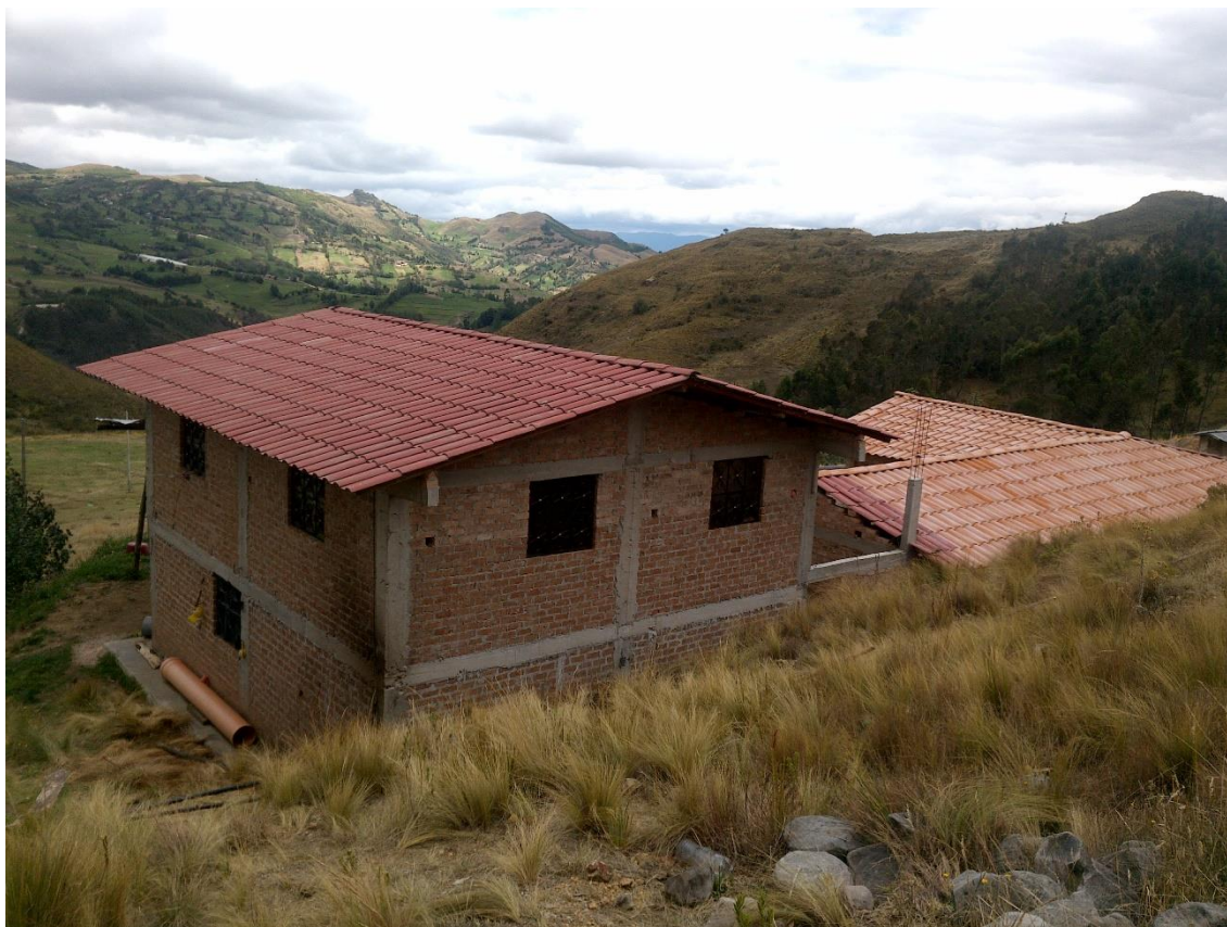
Características constructivas de la vivienda del caserío Hualtipampa Alta
