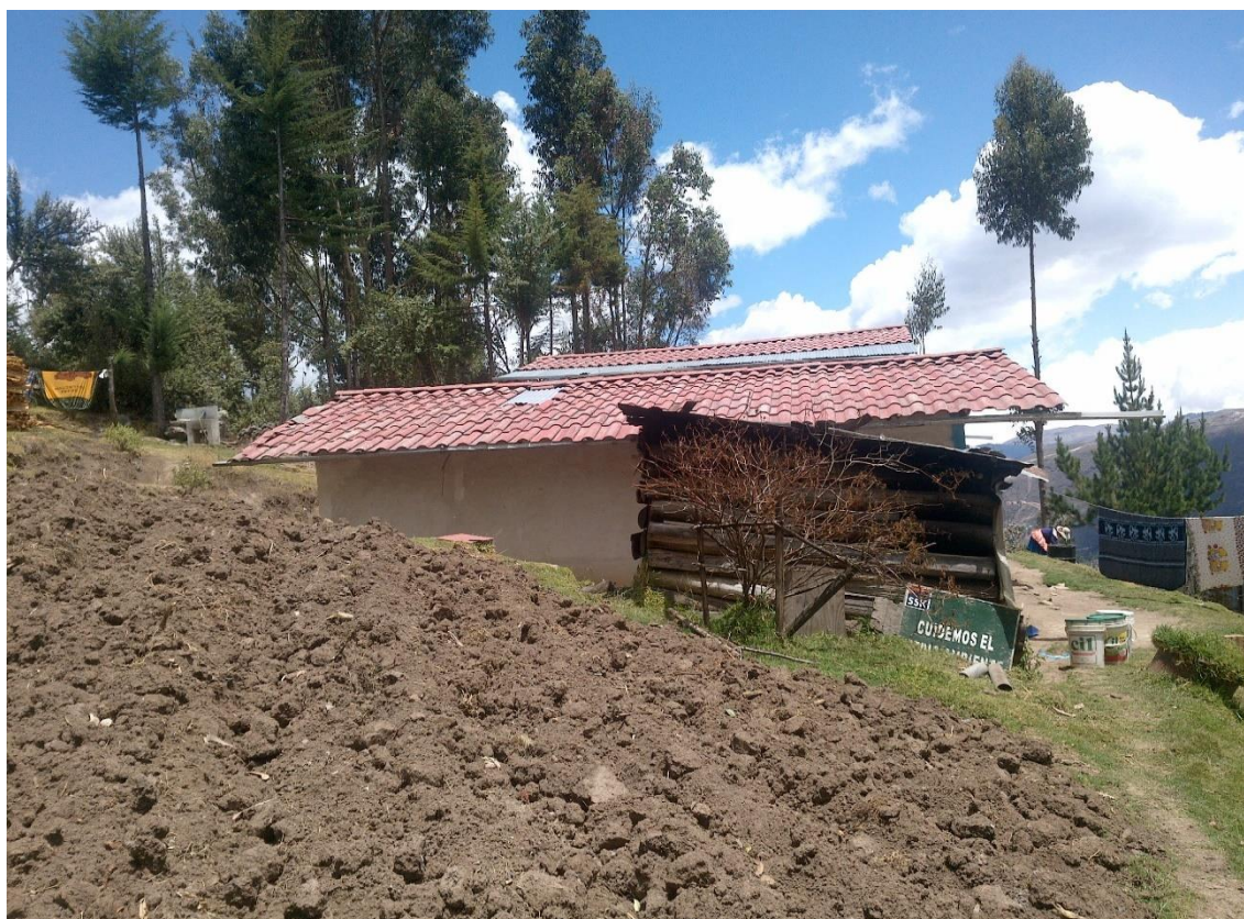
Características constructivas de la vivienda del caserío Yun Yun Bajo
