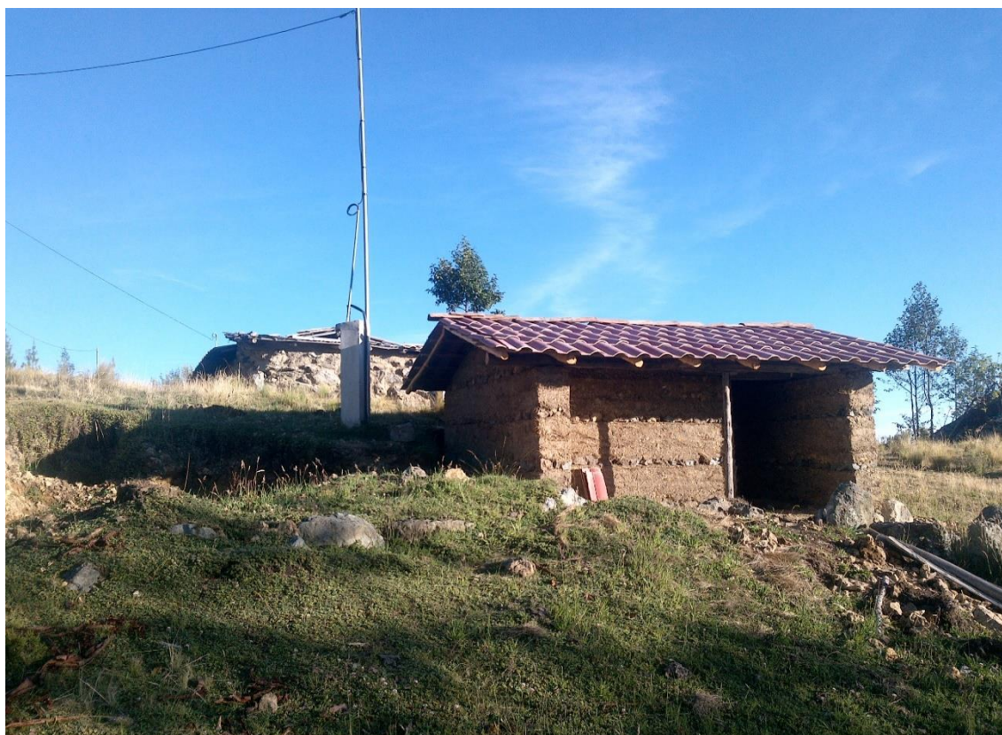
Características constructivas de la vivienda del caserío Puruay Quinuamayo
