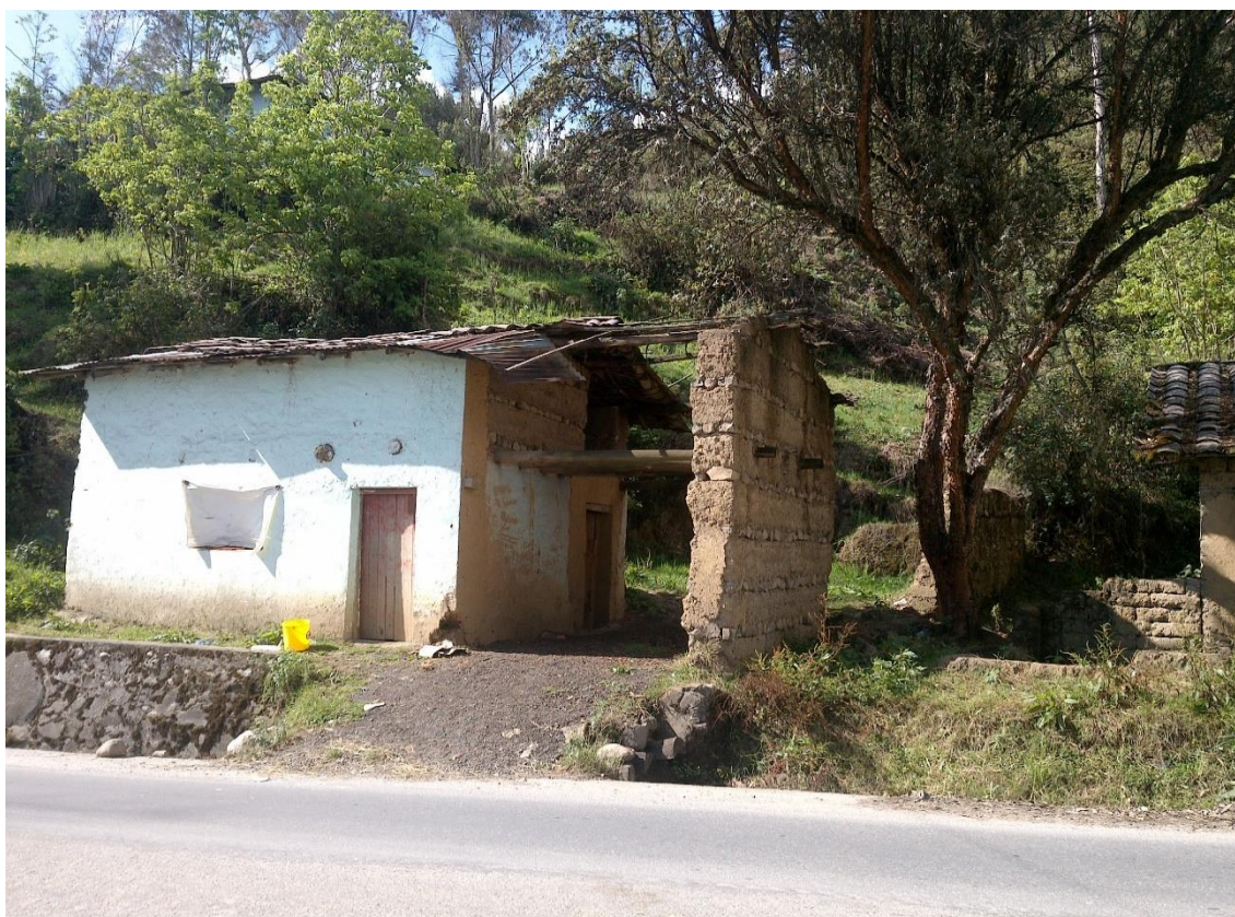
Características constructivas de la vivienda del caserío Quishuarpata
