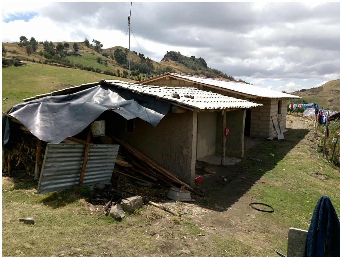
Características constructivas de la vivienda del caserío Purhuay Alto
