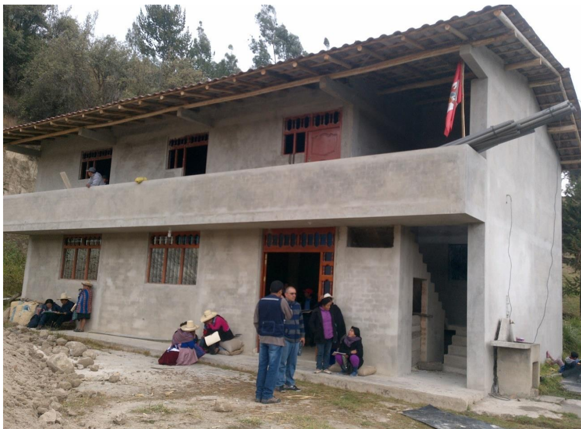
Características constructivas de la vivienda del caserío Purhuay Bajo
