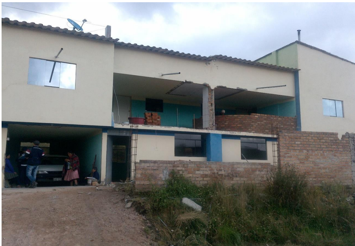
Características constructivas de la vivienda del caserío La Apalina
