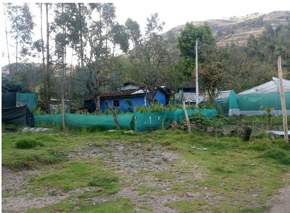
Características constructivas de la vivienda del caserío Huambocancha Chica
