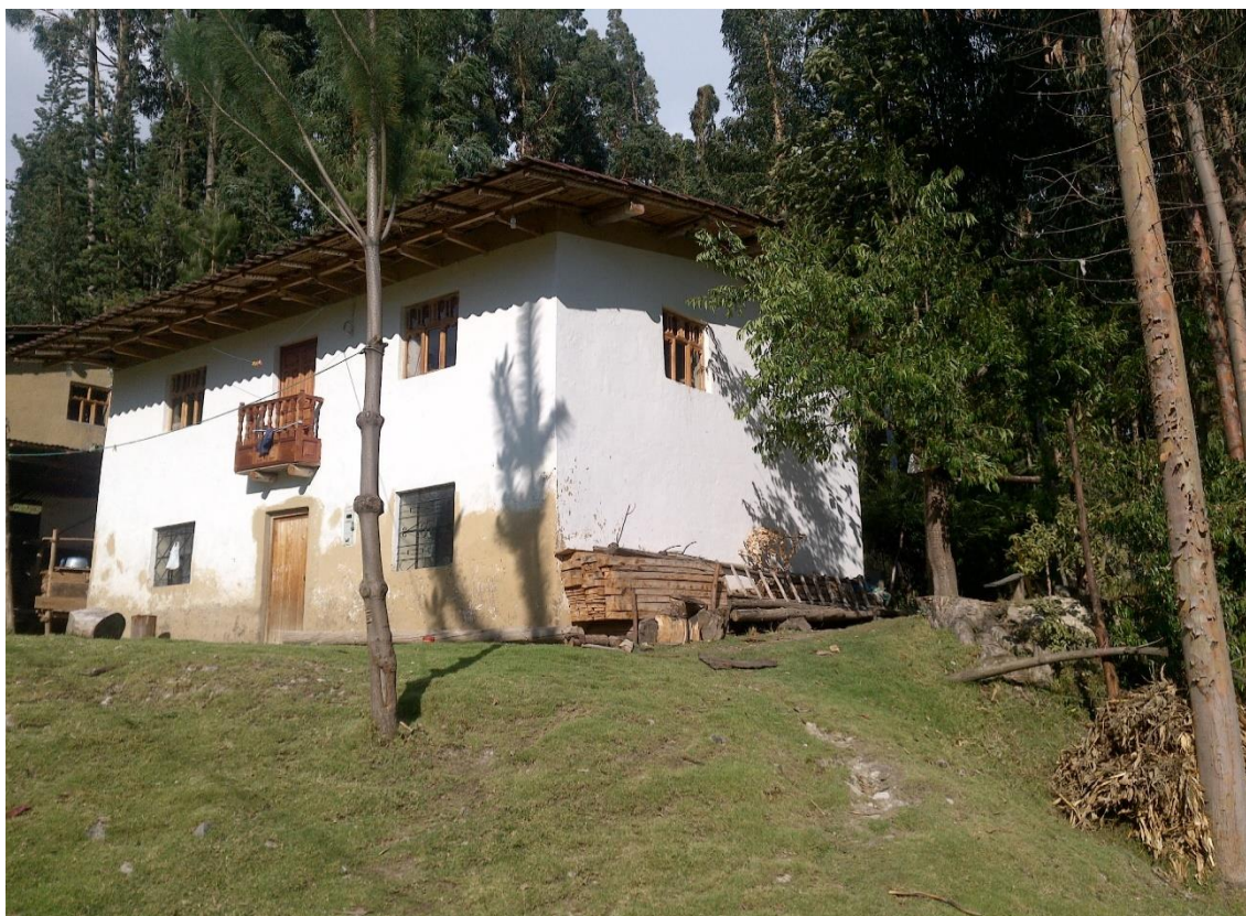
Características constructivas de la vivienda del caserío Santa Rosa
