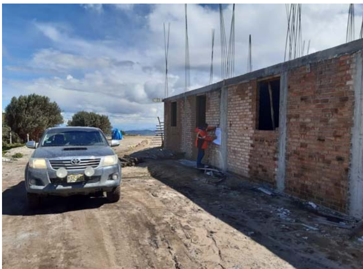
Foto 1: Casa Comunal en construcción del caserío Pabellón de Combayo.
