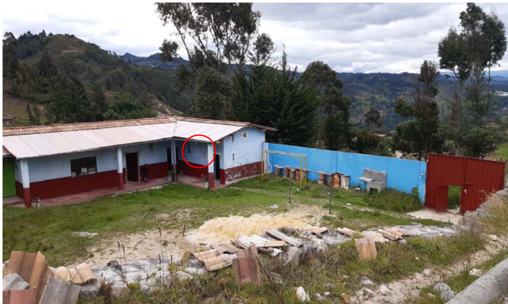
Foto 3: Vista panorámica del aviso adicional pegado dentro de la I.E 821327 – primaria del caserío Llanomayo
