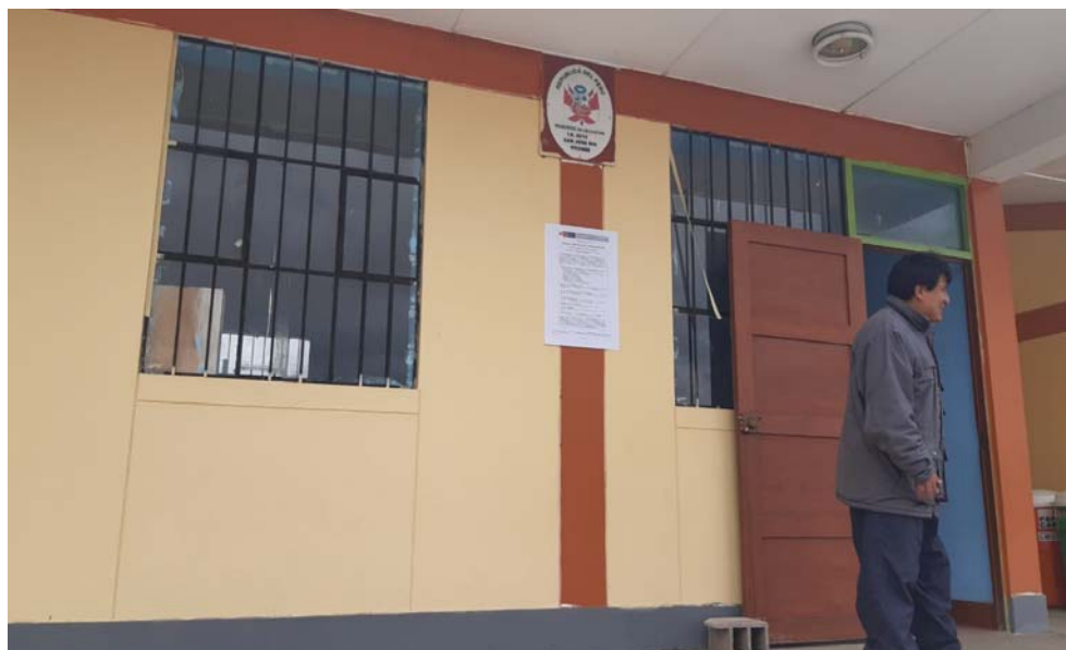
Foto 5: Aviso adicional pegado dentro de la I.E 821552 – primaria del caserío San José.
