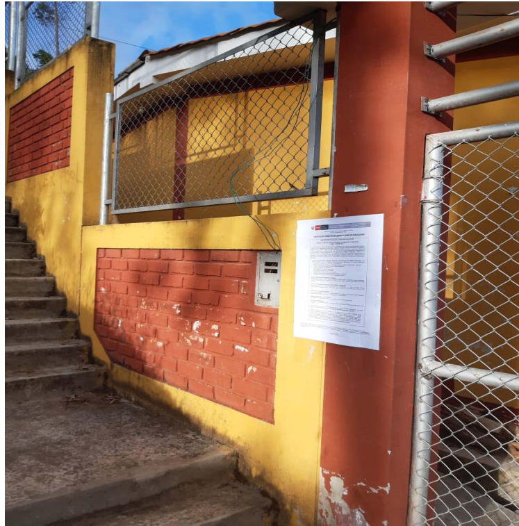
Foto 3: Local Comunal del caserío Quishuarpata.
