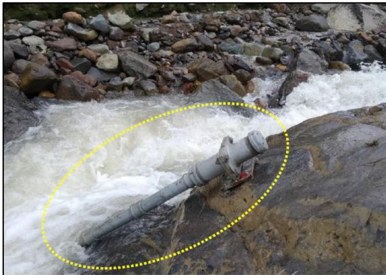
Fotografía 1.- Soporte metálico (transductor de presiones)
