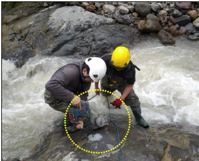
Fotografía 3.- Ejemplo de proceso de instalación de soporte metálico
