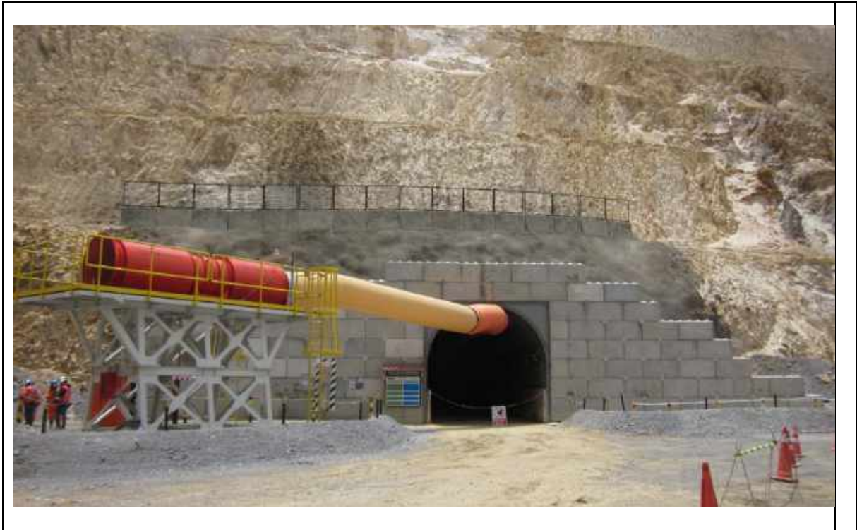
Figura 9-2 Túnel 3800 Este, ejecutado 2017
