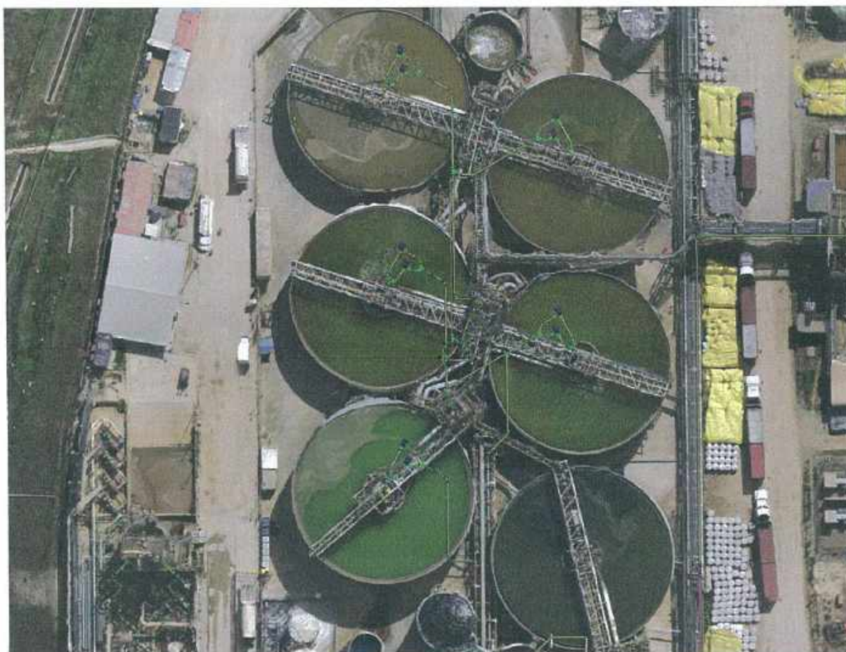
Figura 1-8: Espesadores de lixiviación (las bombas y tuberías se muestran sobre los espesadores para representar su ubicación real debajo de los mismos)
