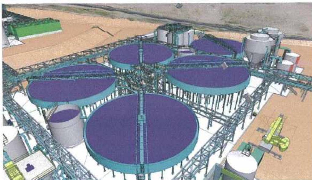
Figura 1-18: La Quinua Oeste - POX CCD/neutralización de solución POX/clarificador de solución POX
