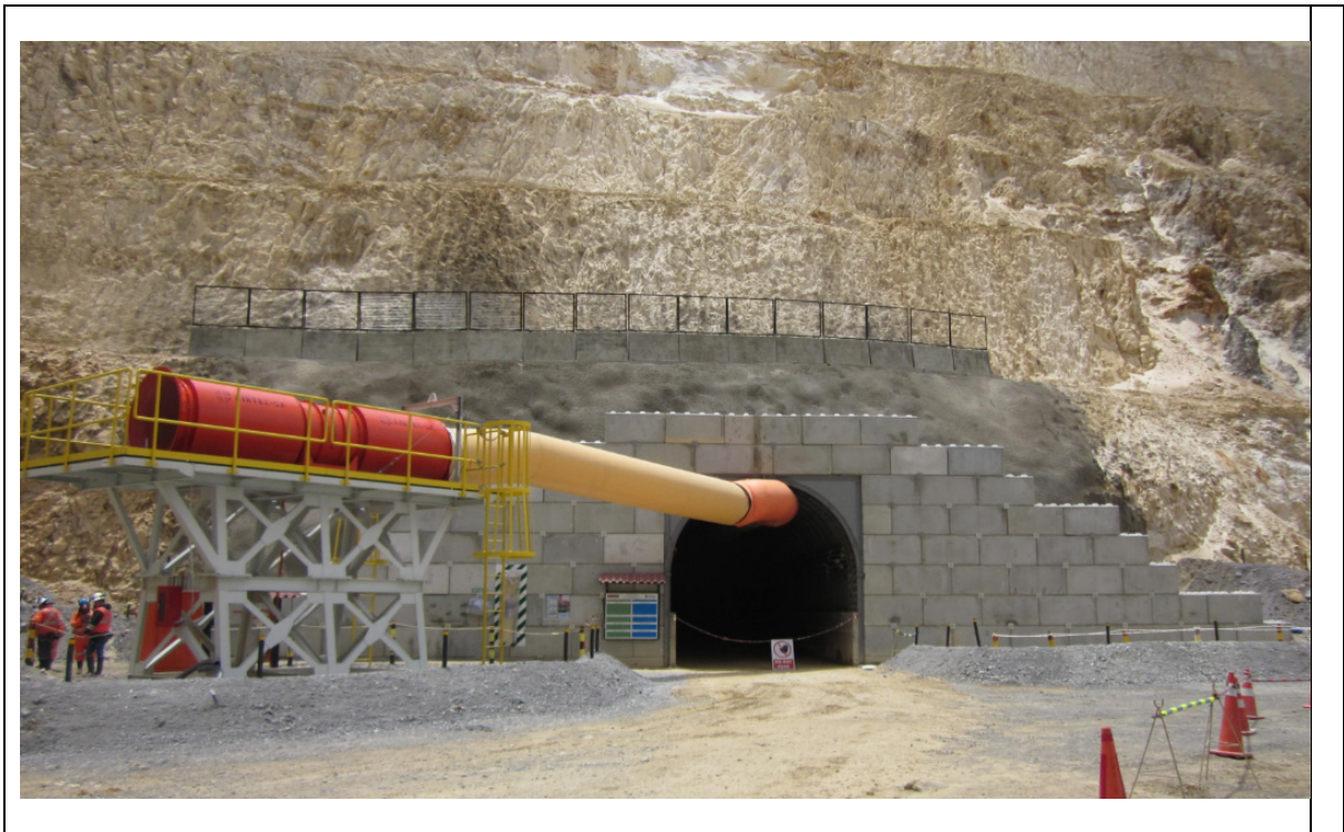
Figura 9-2 Túnel 3800 Este, ejecutado 2017
