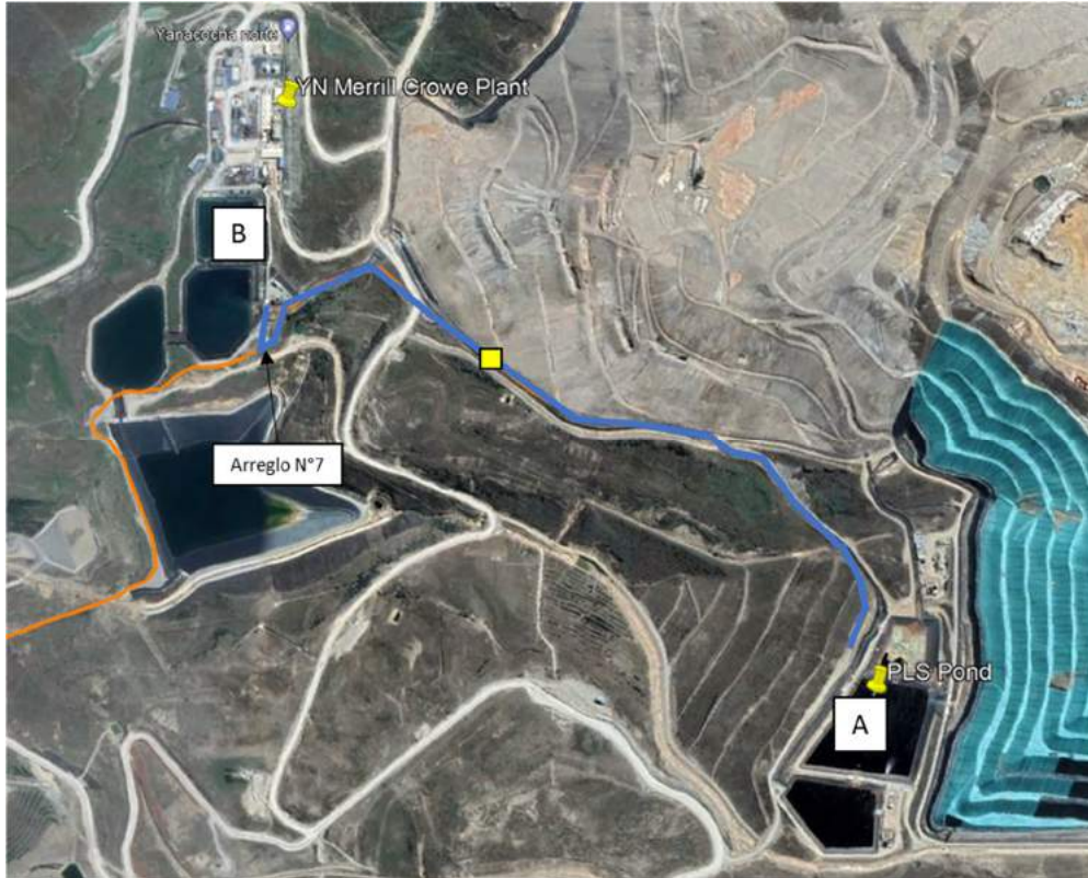
Figura 5-8 Obra general de trinchera desde Piscinas PLS (letra A) hasta planta MC (letra B). Google Earth, 2022.
