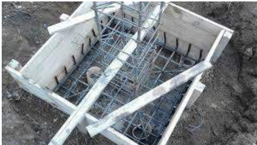
Imagen N° 10 – Encofrado de Pedestales
