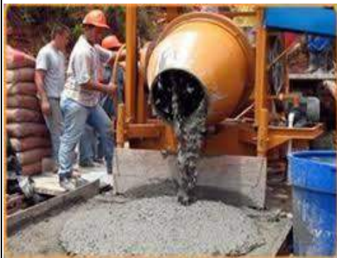
Vaciado de Concreto - Mezcladora
