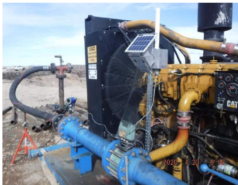
Figura 6. Instalación de la bomba de alta presión
