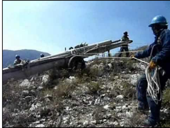
Imagen N° 5 – Traslado de Poste con Maniobra
