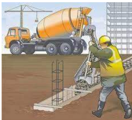
Vaciado de Concreto con Mixer
