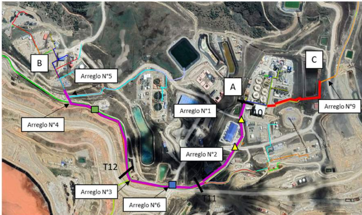
Figura 5-11 Obra general de trinchera entre planta GM (letra A) y LQW (letra B). Color rosa indica trinchera extendida, color rojo indica trinchera nueva (Google Earth, 2022).
