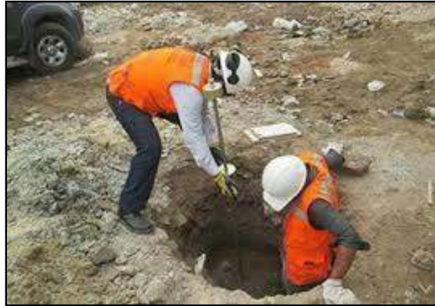
Imagen N° 3 – Excavación de Calicatas para Muestreo de Suelos
