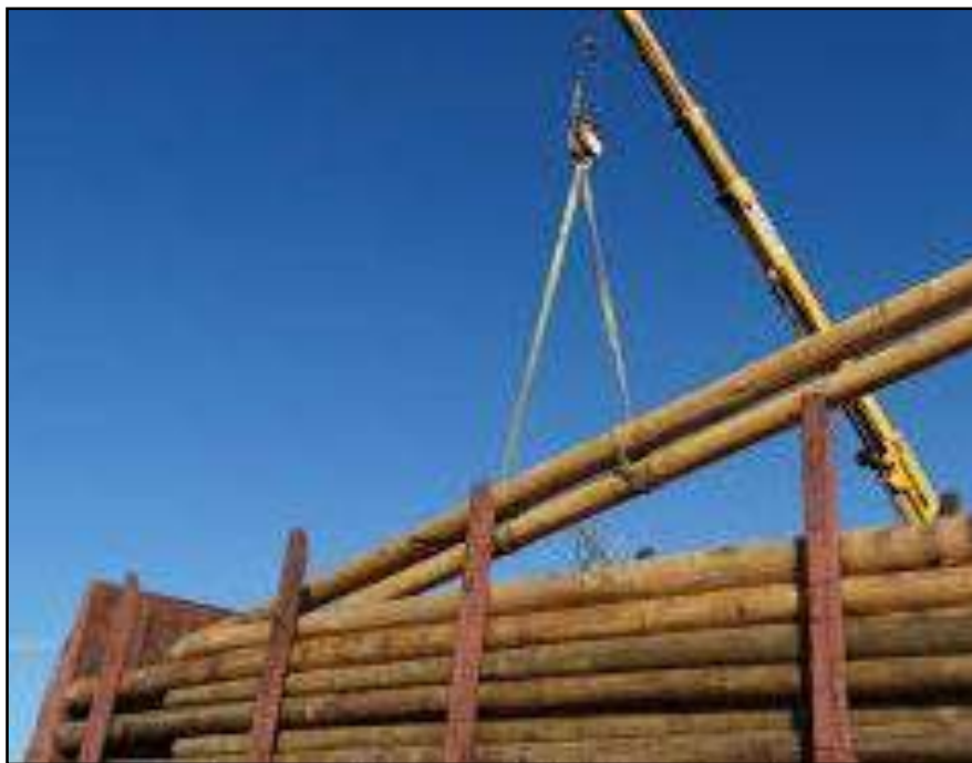
Imagen N° 5 – Traslado de Poste con Maniobra
