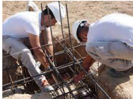
Armado de Estructura en Sitio
