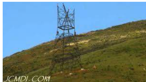
Armado de Torre Celosía
