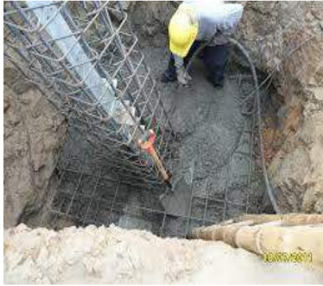
Vaciado de Concreto con Mixer
