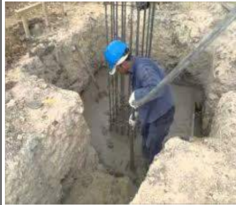
Vaciado de Concreto - Mezcladora
