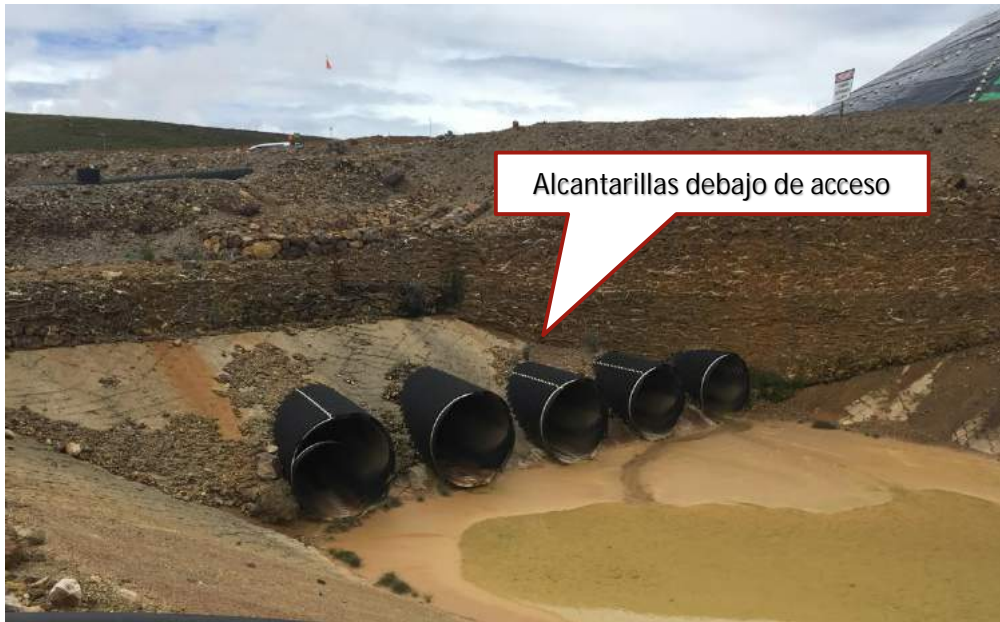
Figura 4-4: Alcantarillado debajo de acceso vehicular
