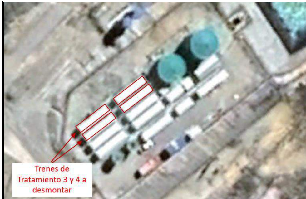
Figura 8: Líneas de Producción de 3 y 4 a Desmontar
