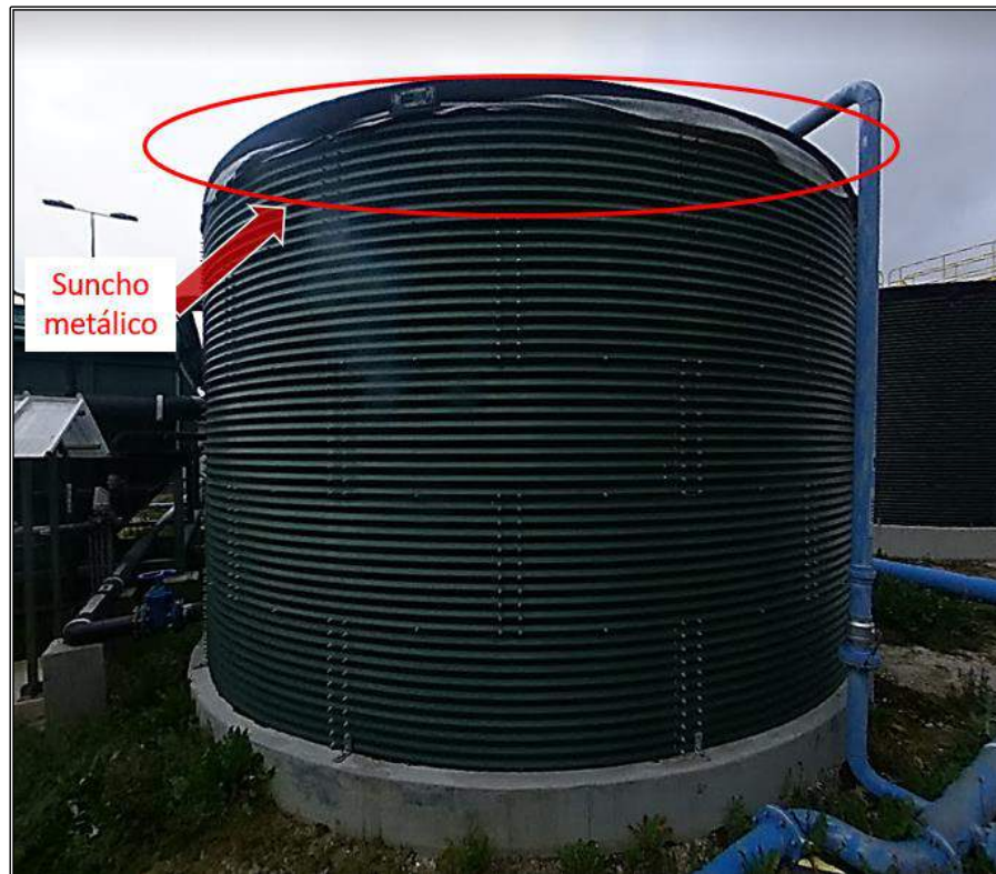
Figura 42: Tanques Empernados
