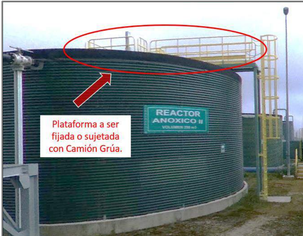
Figura 43: Desmontaje de Estructuras Metálicas
