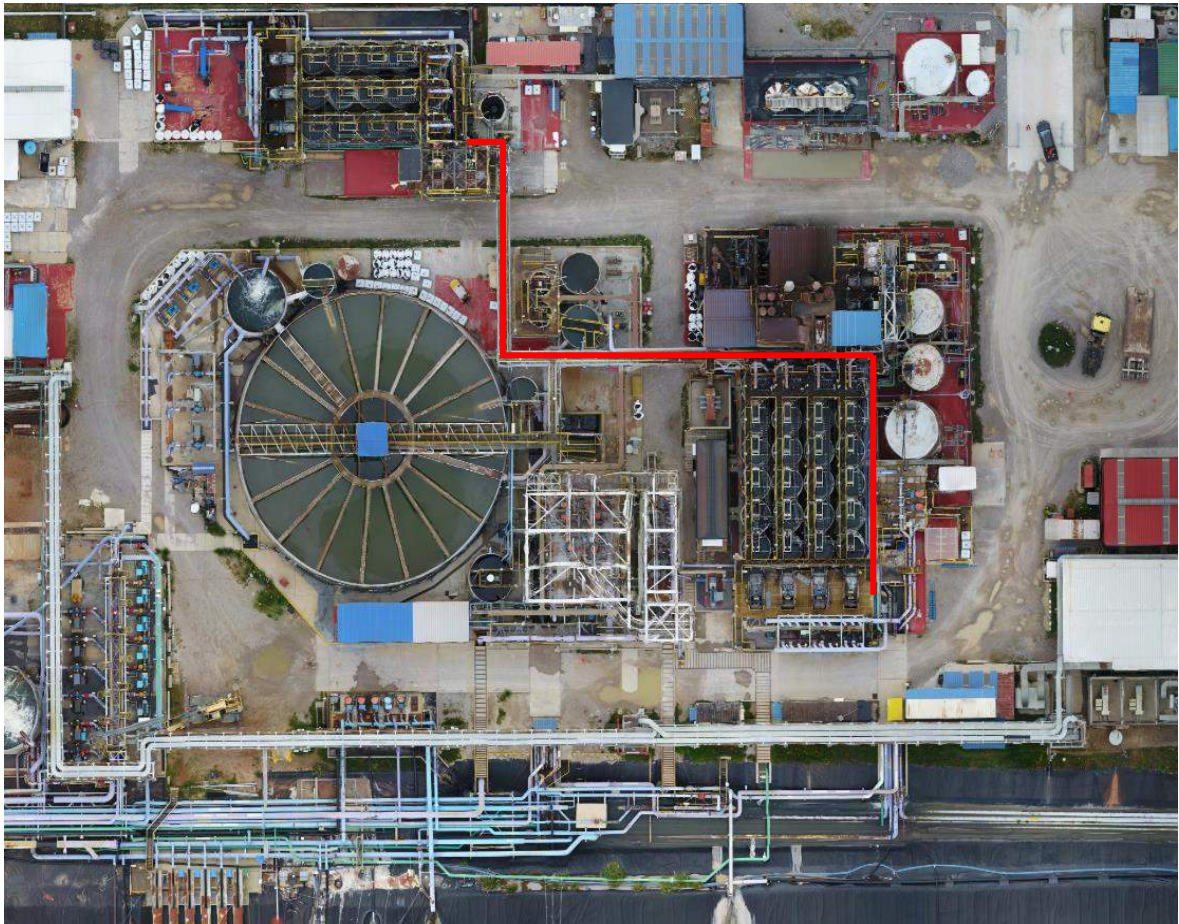
Tramo # 1: Instalación de tubería metálica desde CIC LQ # 2 hacia CIC LQ # 1
