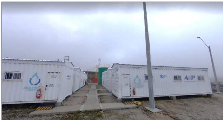
Figura 32: Pararrayos a Desmontar de la PTAP
