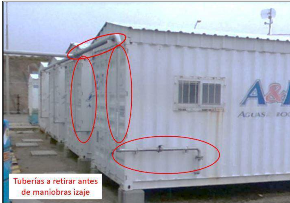
Figura 33: Tuberías a Retirar de Módulos de Tratamiento 3 y 4
