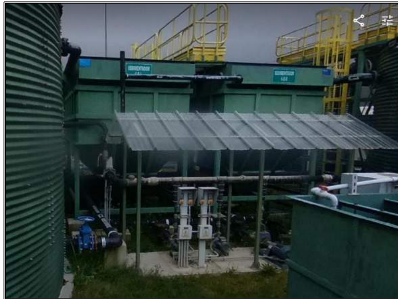
Figura 45: Sedimentadores a Desmontarse
