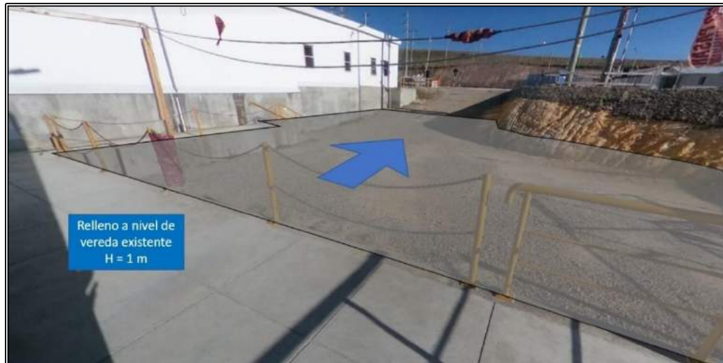
Figura 17 – Proyección de Relleno en Área de Carga y Descarga
