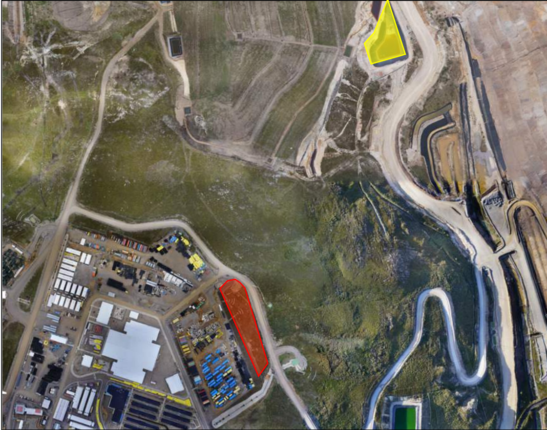
Figura 2-1: Vista en planta ubicación plataforma de embarque y desembarque de buses km 52 (sombreado en rojo) y poza sur (sombreado en amarillo).
