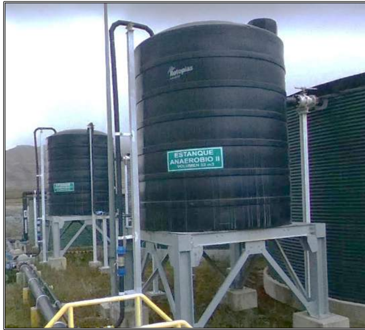
Figura 44: Desmontaje de Tanques Anaeróbicos
