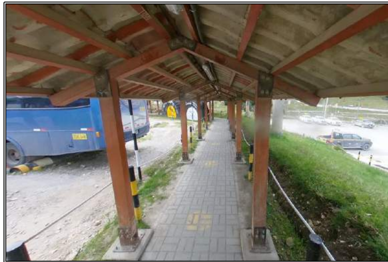
Figura 28: Techo de Madera Existente en Campamento Km 37
