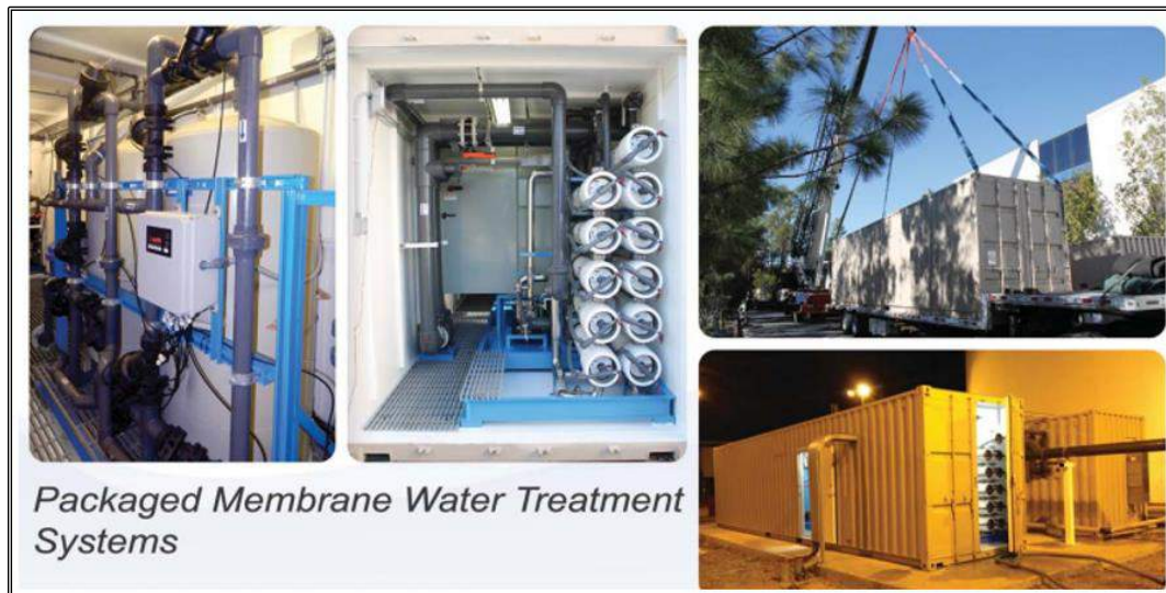
Figura 37: Vista Interior y Exterior de Módulos de 40 Pies
