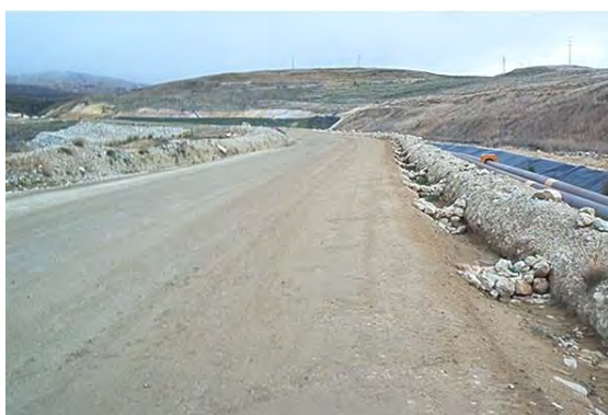
Figura N° 3 Vías de servicio con drenaje adecuado.
