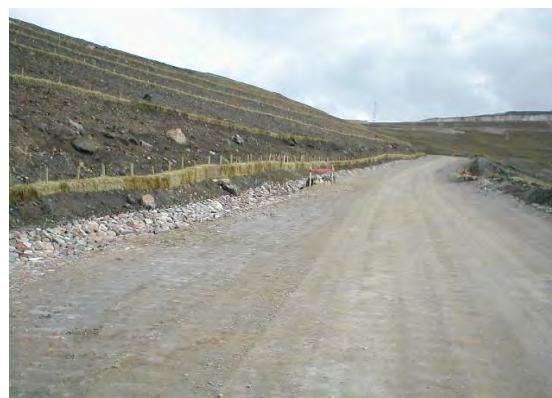
Figura N° 2 Vía con drenaje adecuado y taludes restaurados.
