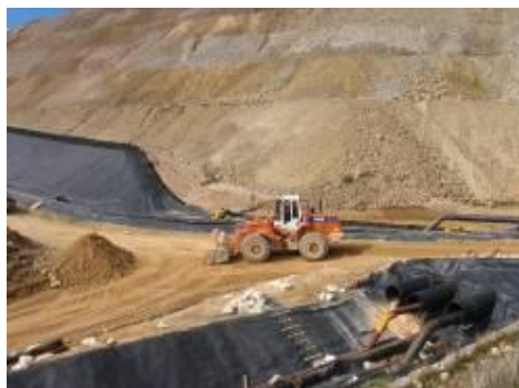
Limpieza con maquinaria
