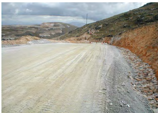
Figura N° 1 Vía con peralte (hacia la cuneta), sistema de drenaje apropiado y talud de corte adecuado.
