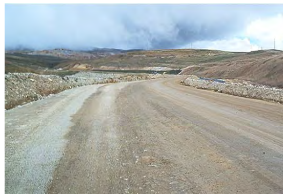
Figura N° 4 Riego de vías para el control de polvo.
